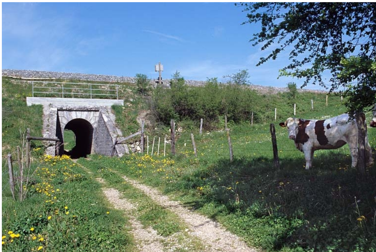
Vue d'ensemble de trois quarts, depuis l'est.
