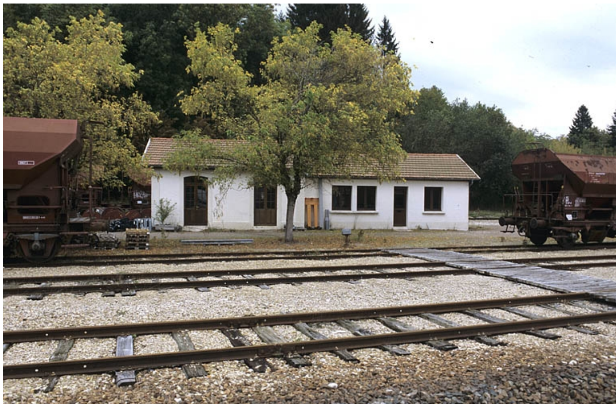
Ancienne lampisterie (bureau des électriciens), de face.
