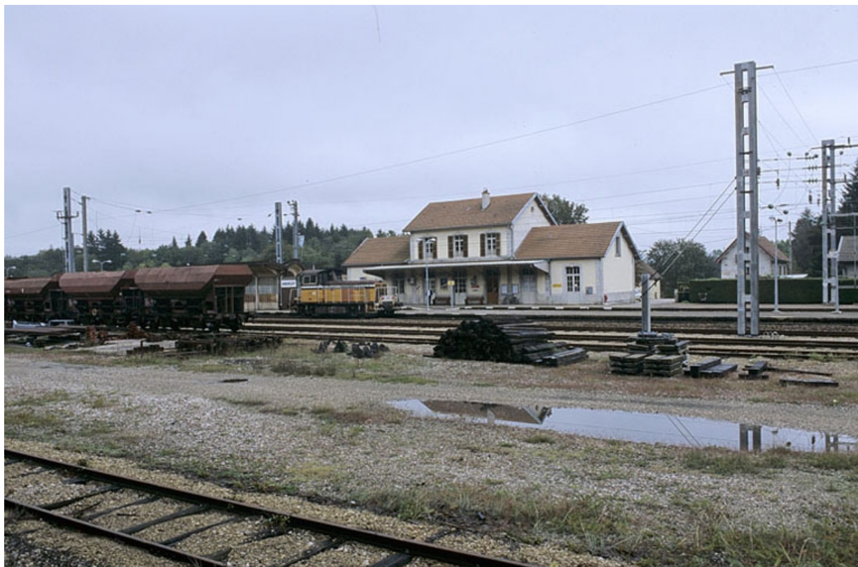
Vue d'ensemble, depuis le nord-ouest (voies côté Dijon).
