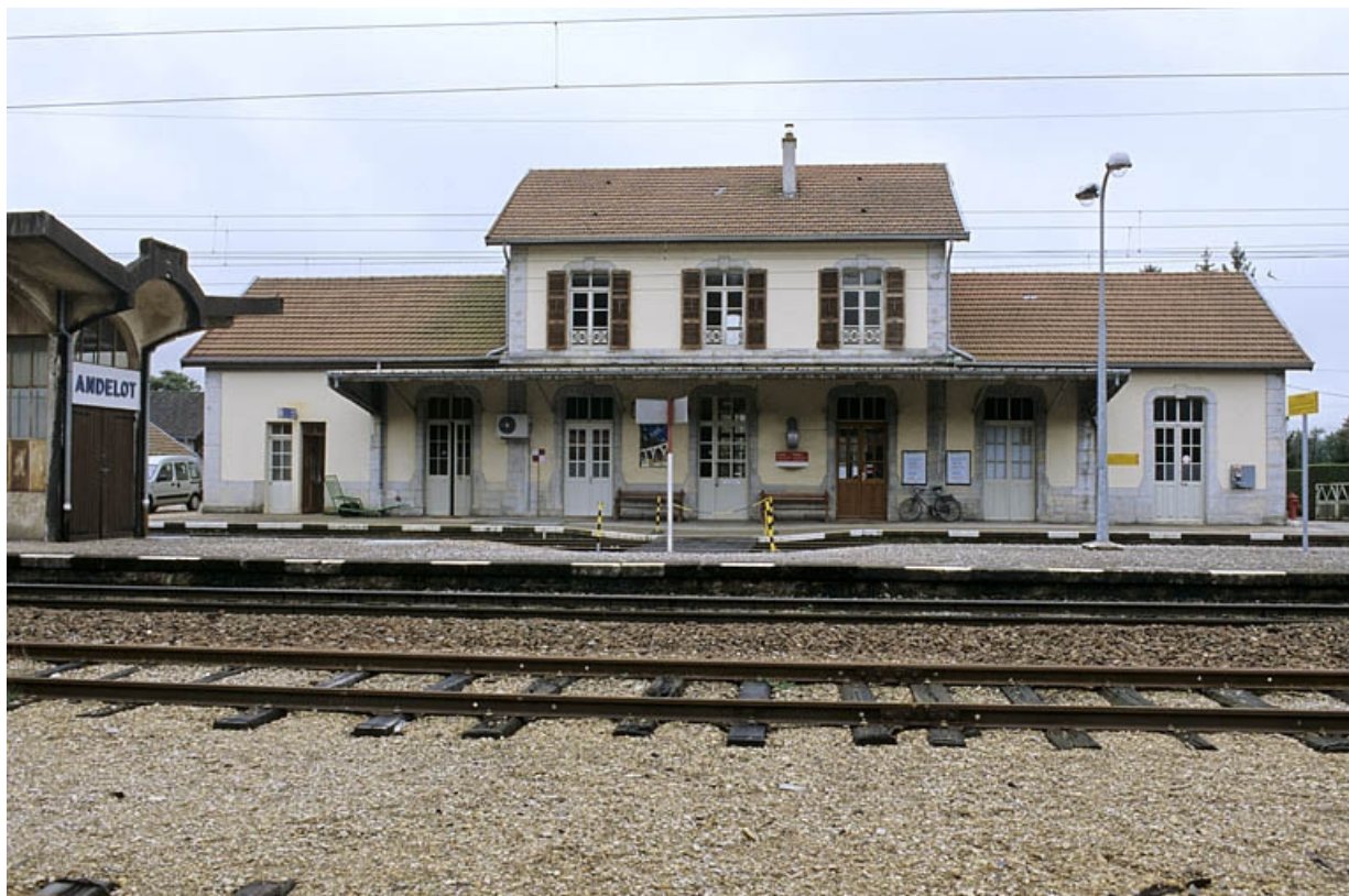
Bâtiment des voyageurs : façade postérieure, de face.
