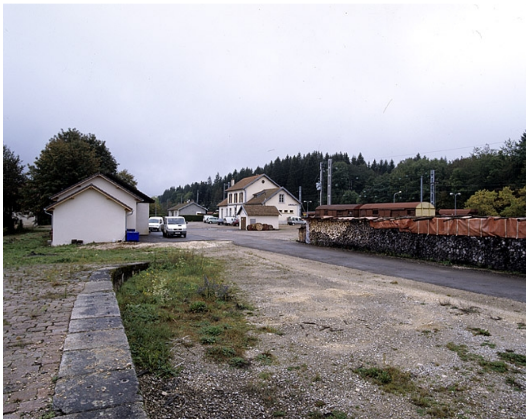
Vue d'ensemble, depuis le nord-est (cour des marchandises).
