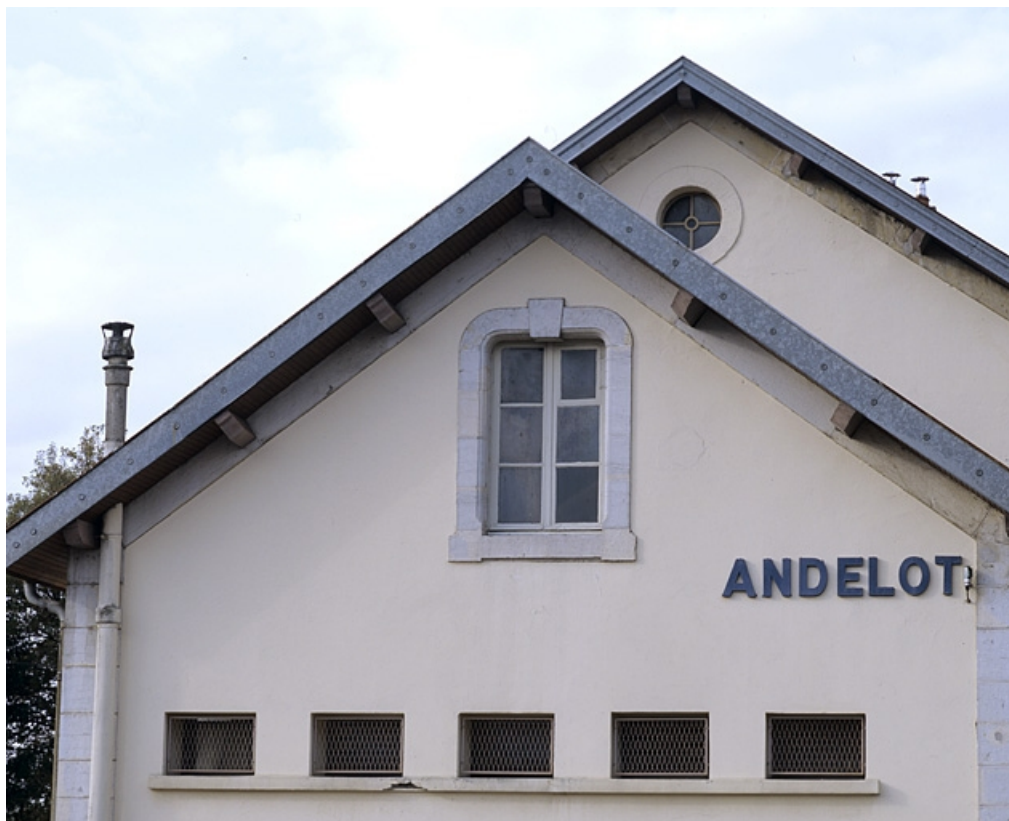
Bâtiment des voyageurs : pignon de l'aile droite.
