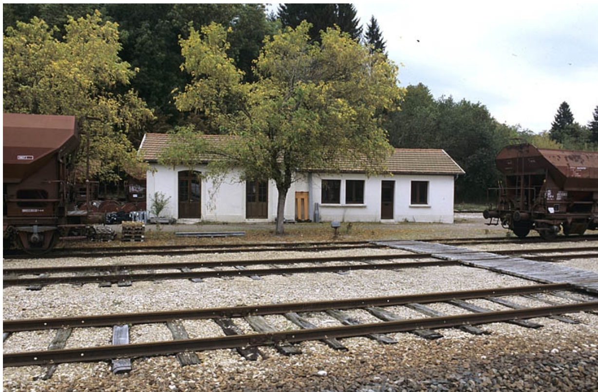
Ancienne lampisterie (bureau des électriciens), de face.
