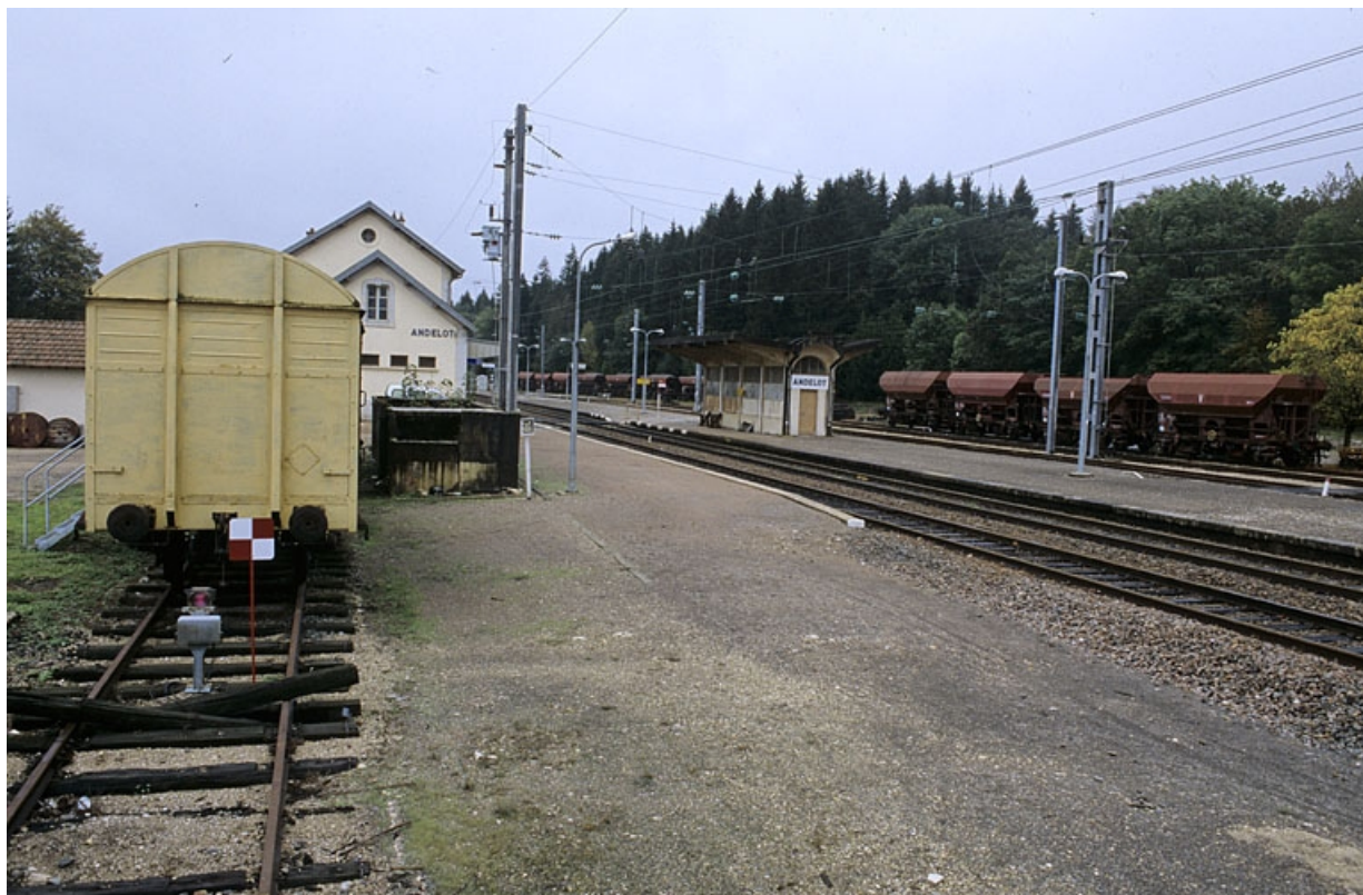
Vue d'ensemble rapprochée, depuis le nord-est (côté Vallorbe).
