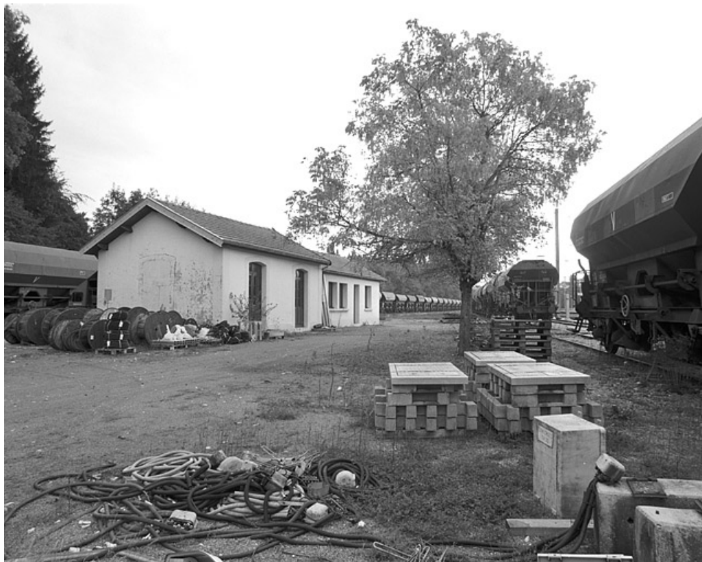
Ancienne lampisterie (bureau des électriciens), de trois quarts gauche.
