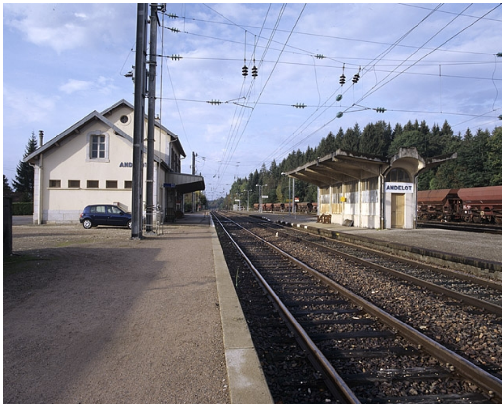
Bâtiment des voyageurs : vue d'ensemble de l'aile droite (côté Vallorbe).
