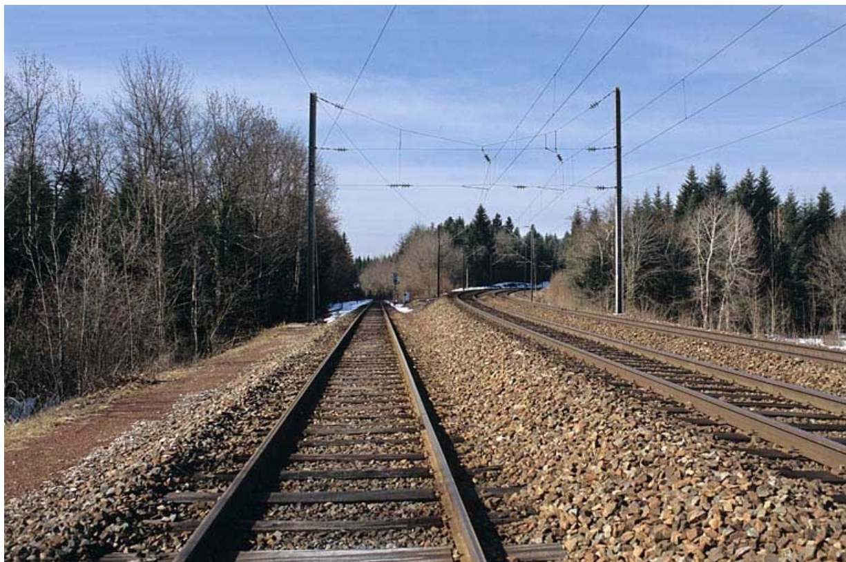
Séparation des lignes Andelot-en-Montagne - La Cluse (à gauche) et Dijon - Vallorbe.
