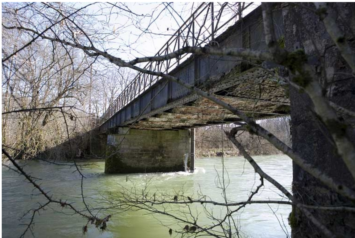
Vue en enfilade, depuis la rive gauche en aval.
