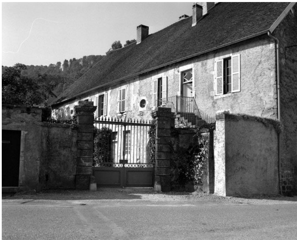
Façade antérieure et portail d'entrée.
