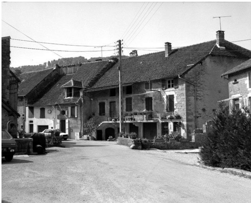
Maison située rue des Vignerons : façade antérieure vue de trois quarts droit. 39, Vernantois
