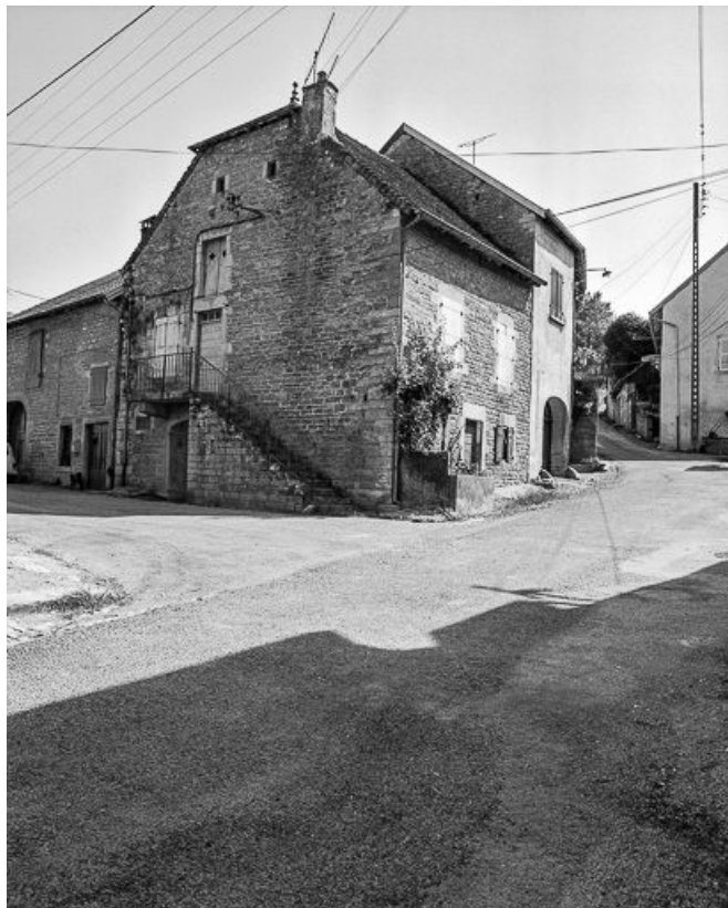
Façades antérieure et latérale gauche
