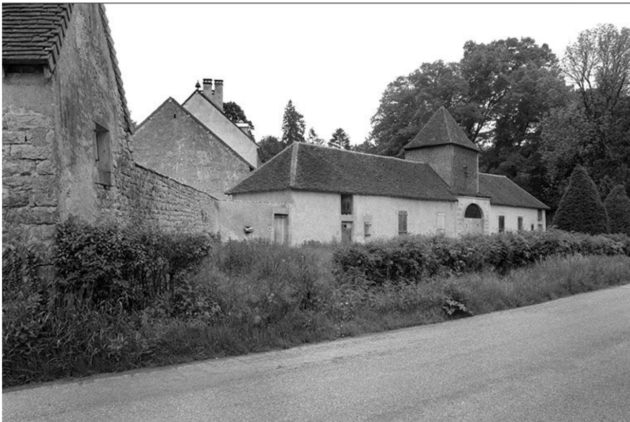
Les communs vus depuis la route.
