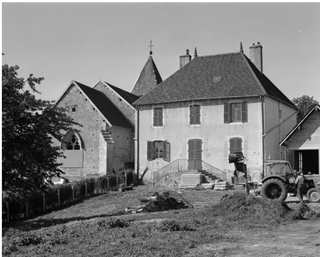
Mairie située rue des Ecoles, à côté de l'église : façade postérieure. 39, Courlaoux
