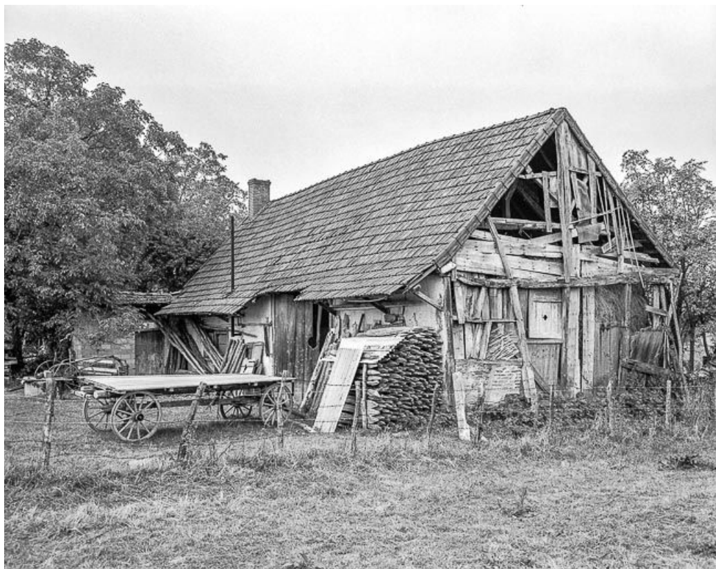
Façade antérieure et face droite.
