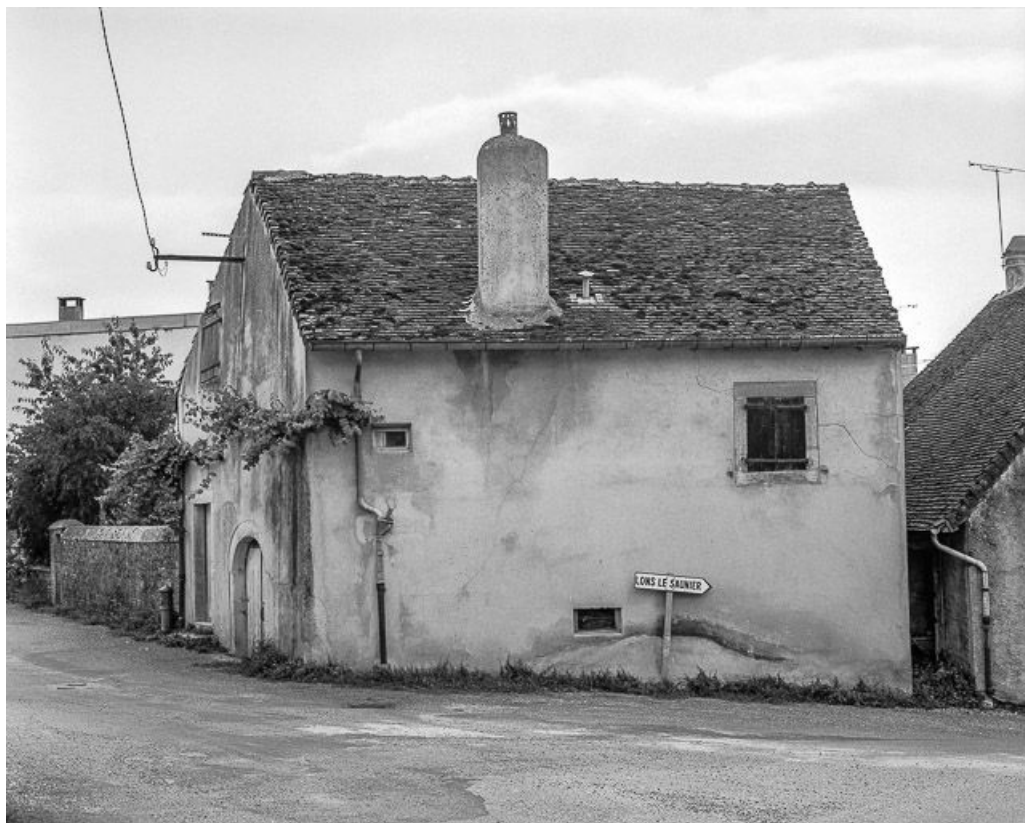
Façade latérale gauche. 39, Chille
