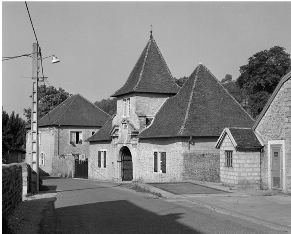
Pavillon d'entrée, élévation sur la rue.
