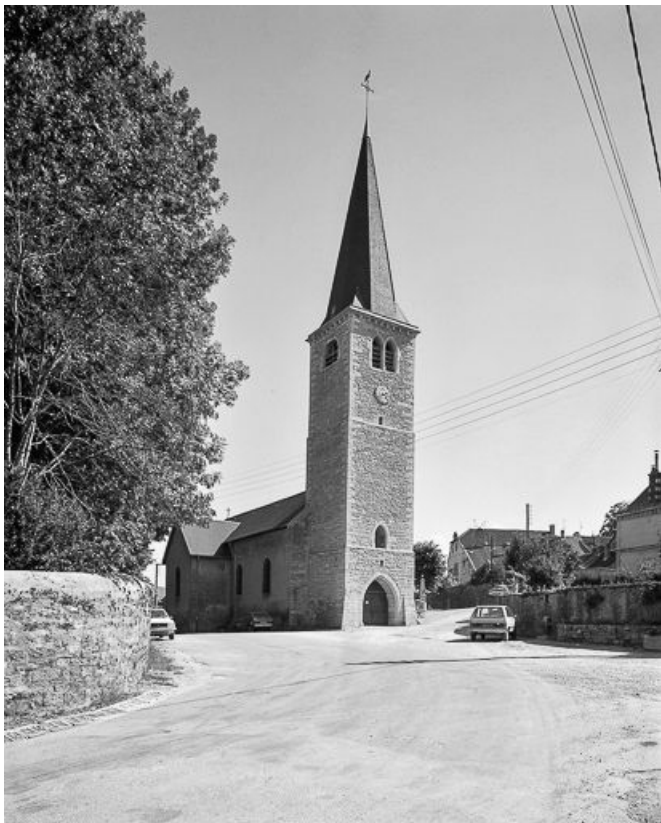
Façades antérieure et latérale gauche.
