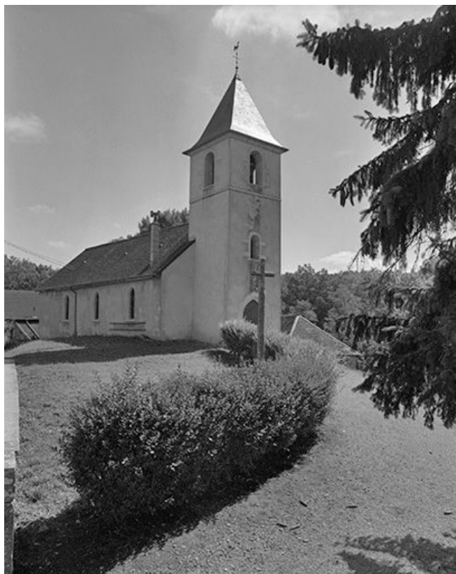
Façades antérieure et latérale gauche.
