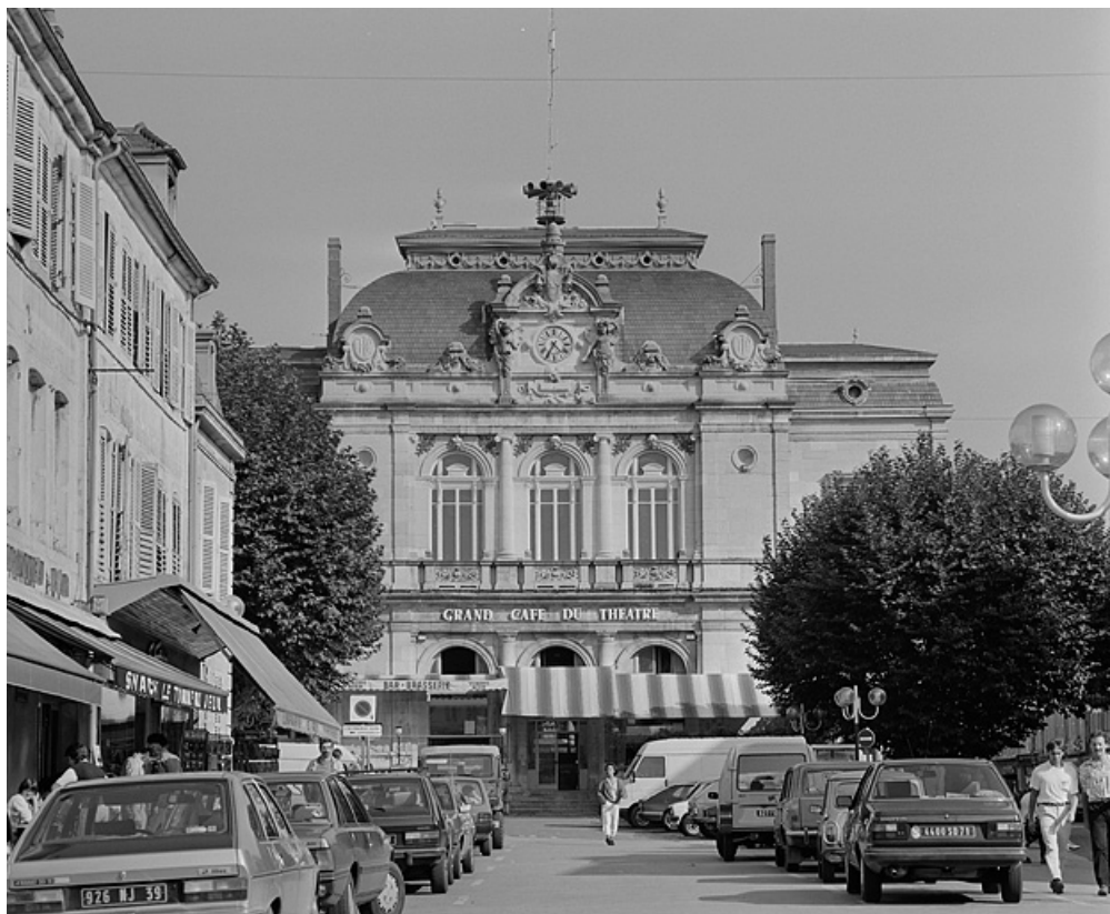
Façade antérieure, vue générale.
