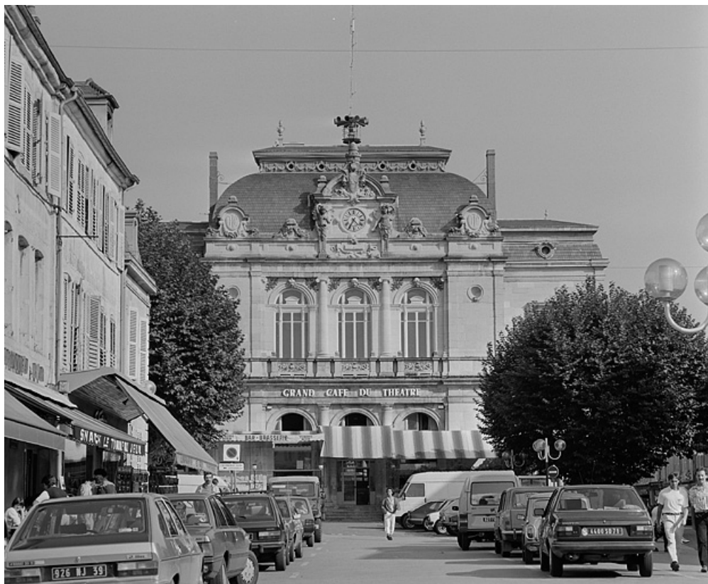
Façade antérieure, vue générale.
