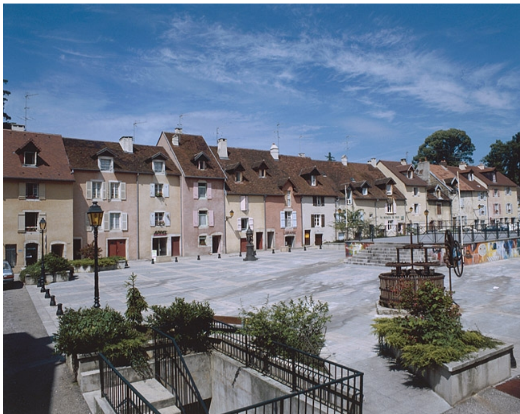
Vue générale de la place de la Comédie. 39, Lons-le-Saunier
