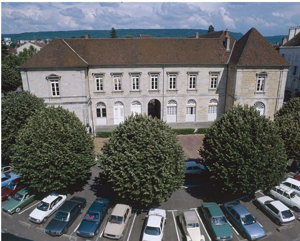
Façade ouest, vue d'ensemble.
