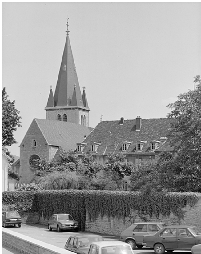
Eglise Saint-Désiré, vue générale depuis l'ouest.
