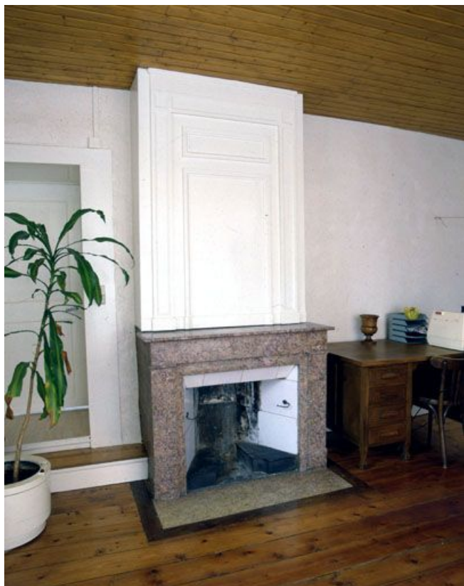
La cheminée de la chambre servant de lingerie.
