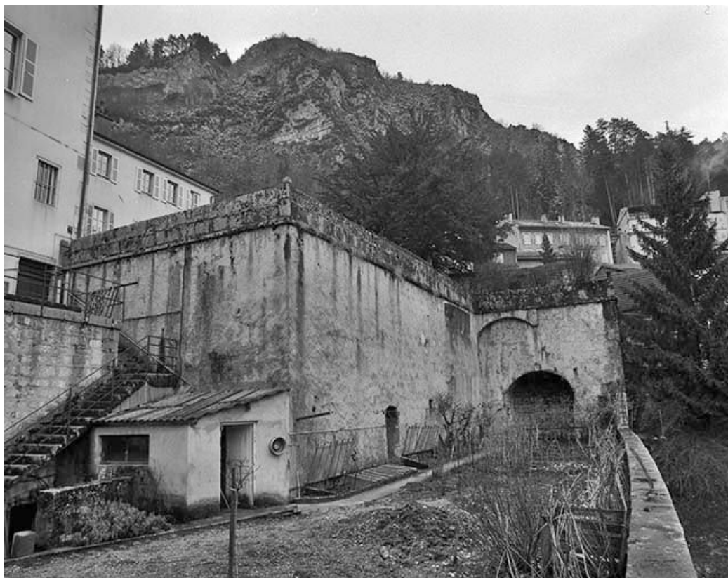
Mur de soubassement du jardin et abside de la chapelle Saint-Sébastien.
