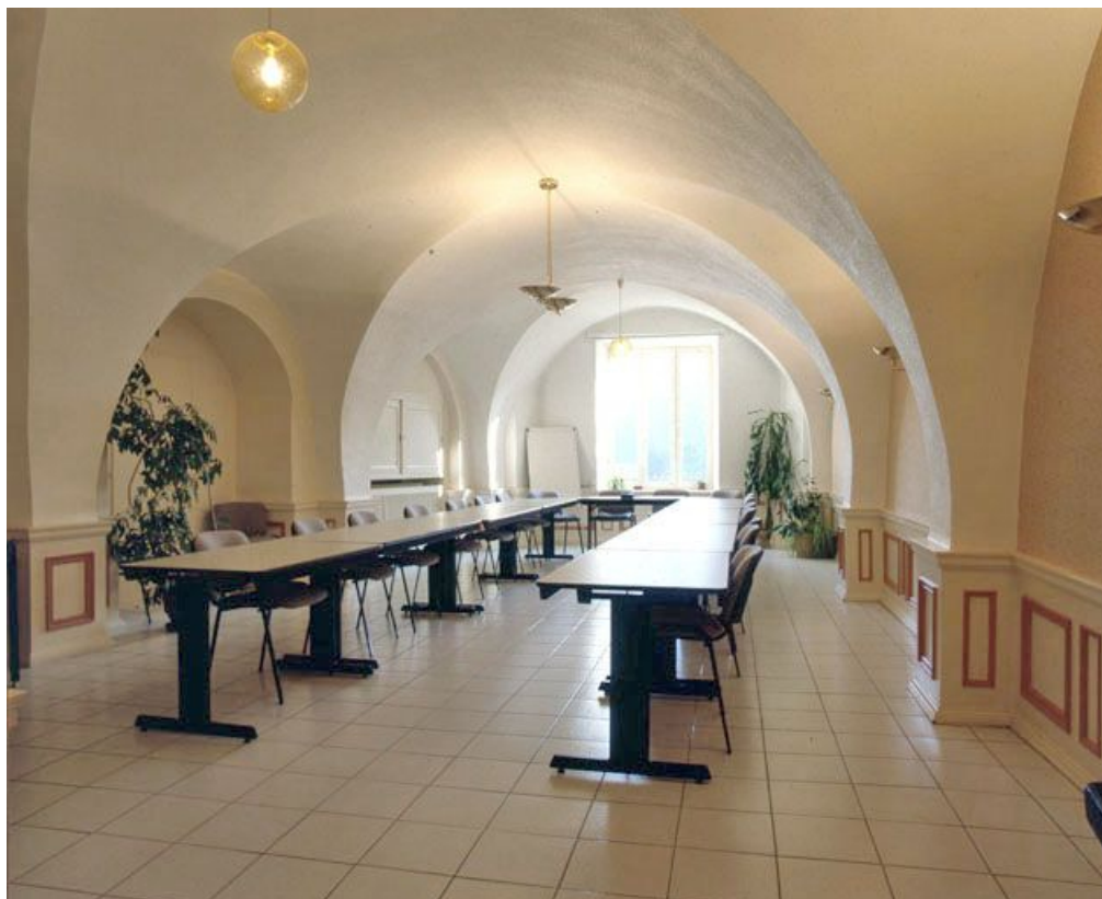
Ancienne salle des infirmeries voûtée d'arêtes, actuellement salle de réunion. 39, Saint-Claude, 2 rue de la Sous-préfecture
