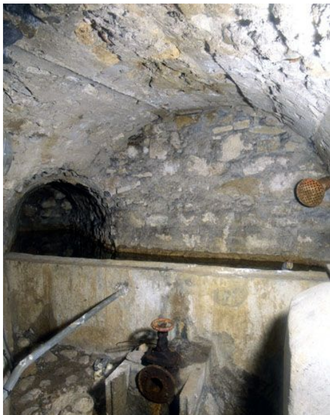
Conduit hydraulique des infirmeries, vue de la source.
