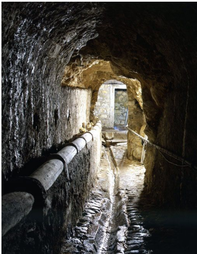
Conduit hydraulique des infirmeries vu depuis la source.
