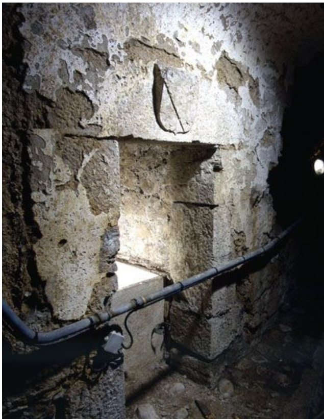
Bassin dans le conduit hydraulique des infirmeries, vu de trois quarts.
