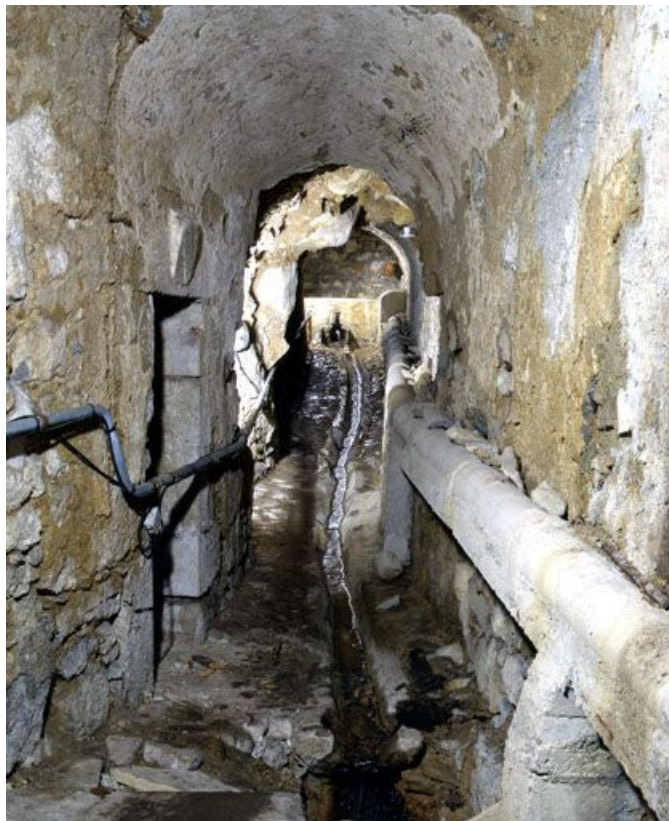
Conduit hydraulique des infirmeries vu depuis l'entrée.
