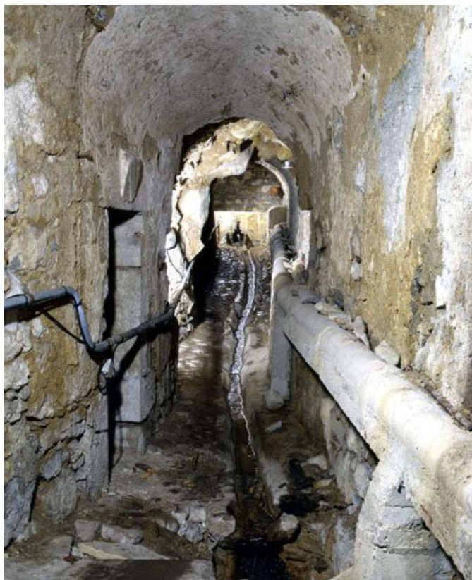
Conduit hydraulique des infirmeries vu depuis l'entrée.
