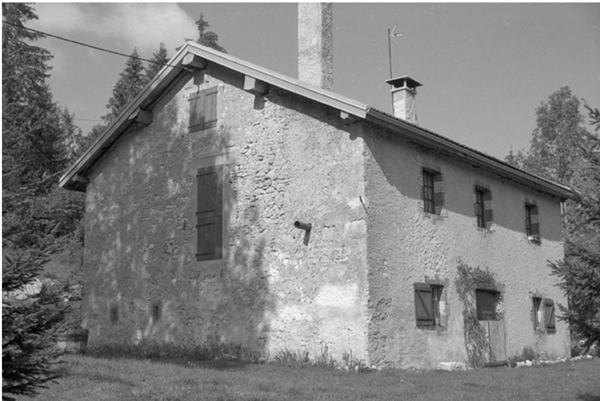
Vue générale de la fromagerie de la Combe Servagnat, à Longchaumois.
