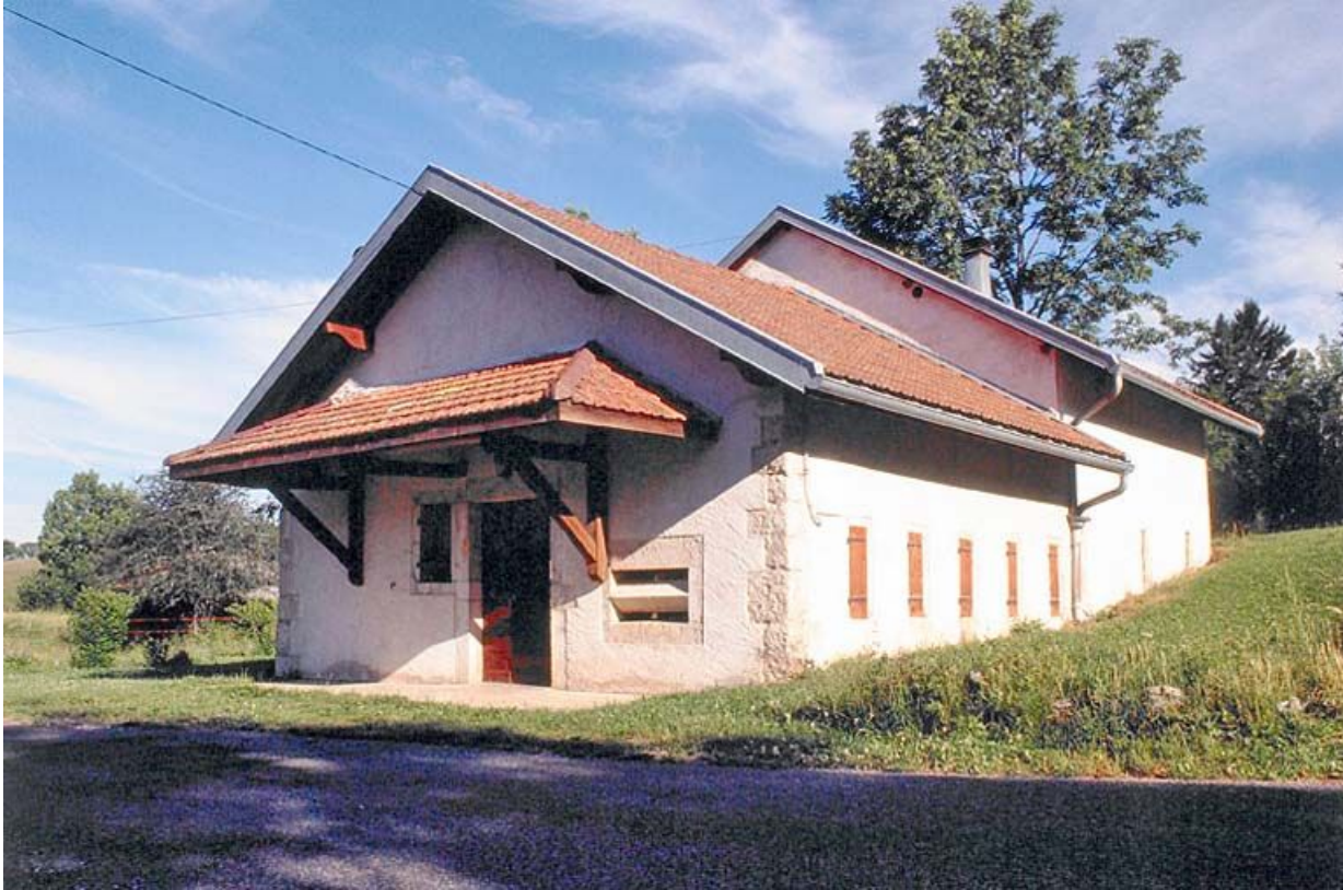
Façade antérieure de la fromagerie du hameau des Communailles, à Longchaumois, vue de trois quarts.
