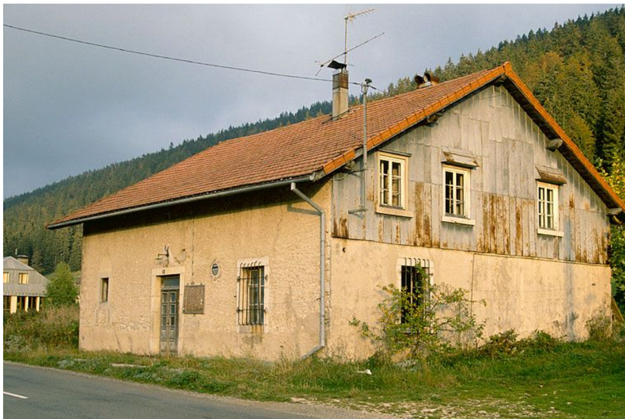
Vue générale de la fromagerie des Landes d'Aval, à Bois-d'Amont.
