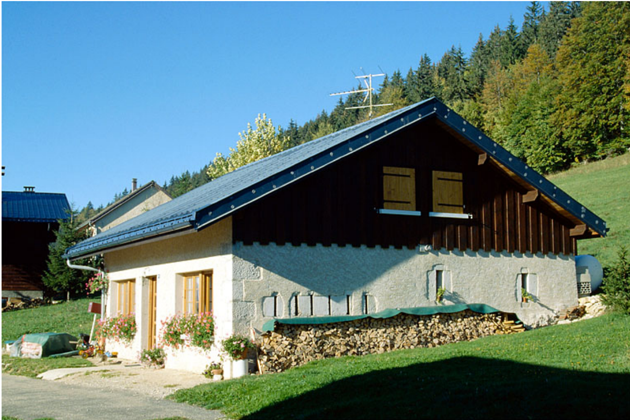
Vue générale de la fromagerie des Meuniers, à Bois-d'Amont.
