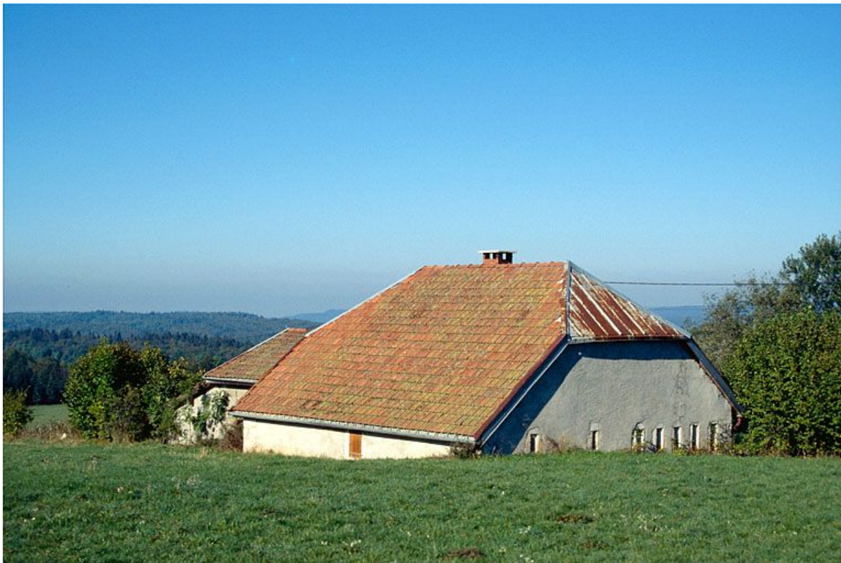
Vue générale de la fromagerie des Raisses, à Longchaumois.
