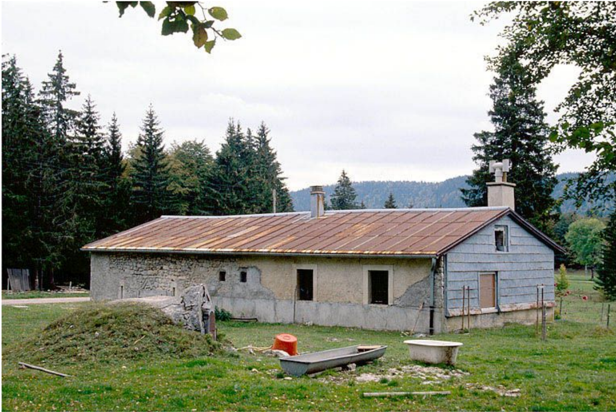
Vue générale de la fromagerie de la Chaux Mourant, à Bellefontaine.
