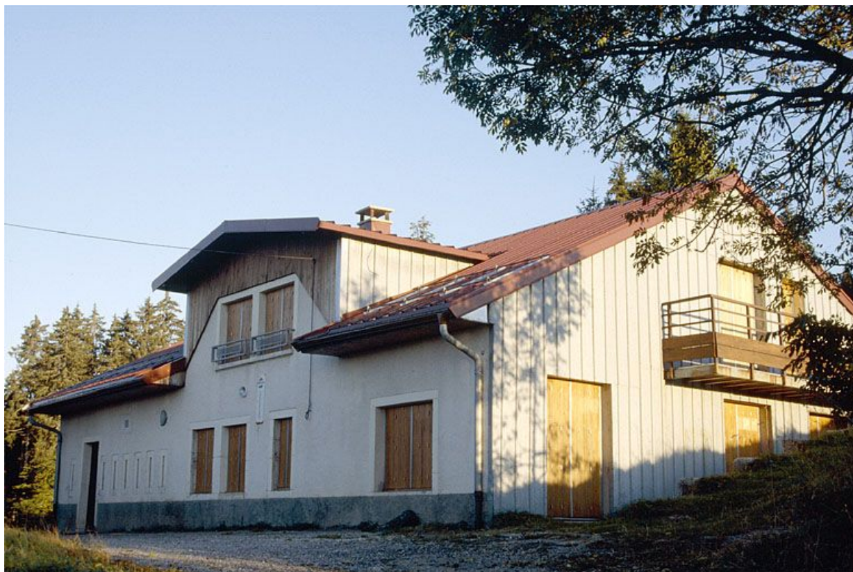
Vue générale de la fromagerie de la Halle, à Prémanon.
