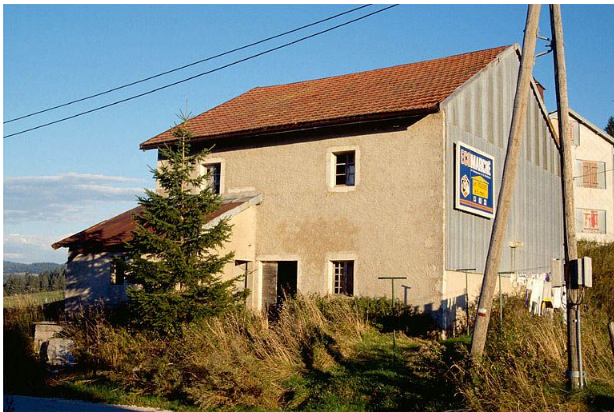
Façade postérieure de la fromagerie du village de Prémaman.
