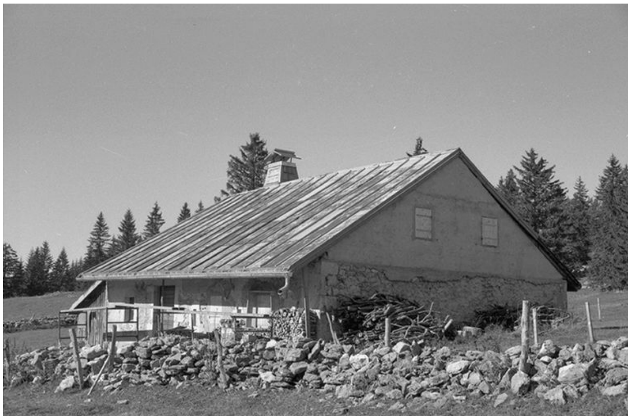
Façade antérieure de la fromagerie des Loges, à Bois-d'Amont.
