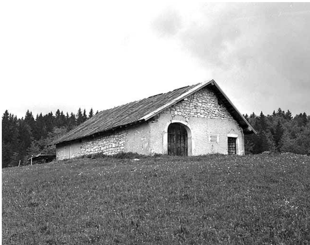
Façade antérieure et face gauche d'une étable à vaches.
