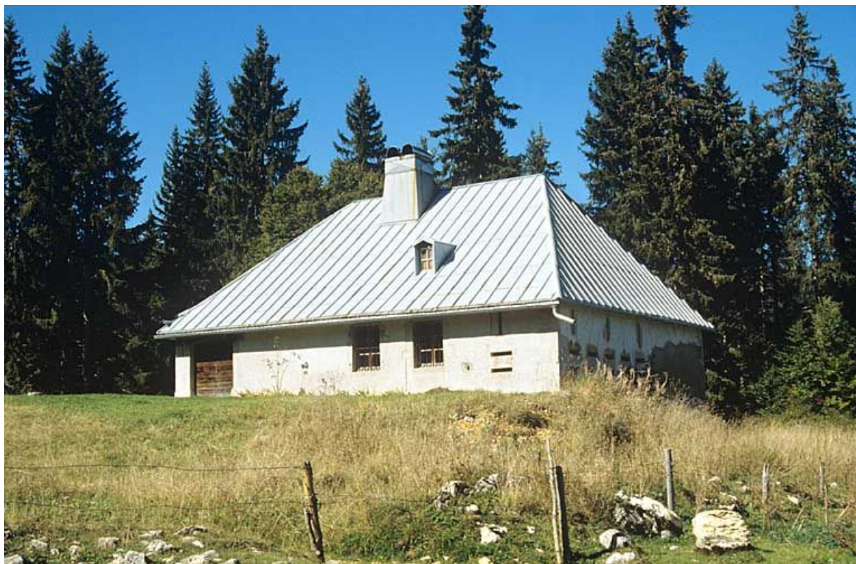
Vue générale de la façade antérieure du chalet d'estive du Petit Boulu.
