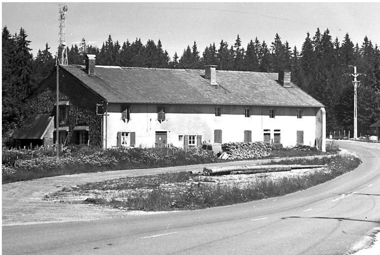
Vue éloignée de la façade antérieure.
