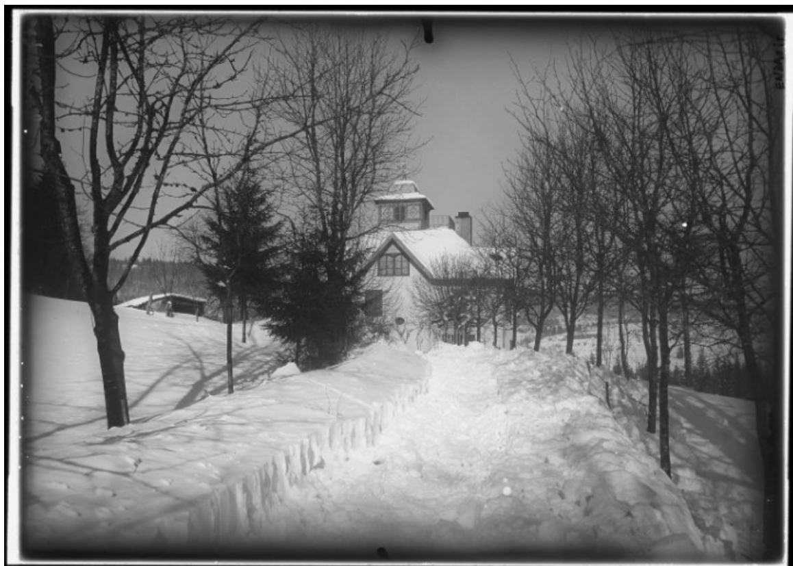
[Façade antérieure en hiver, vue éloignée], 1er quart 20e siècle ?
