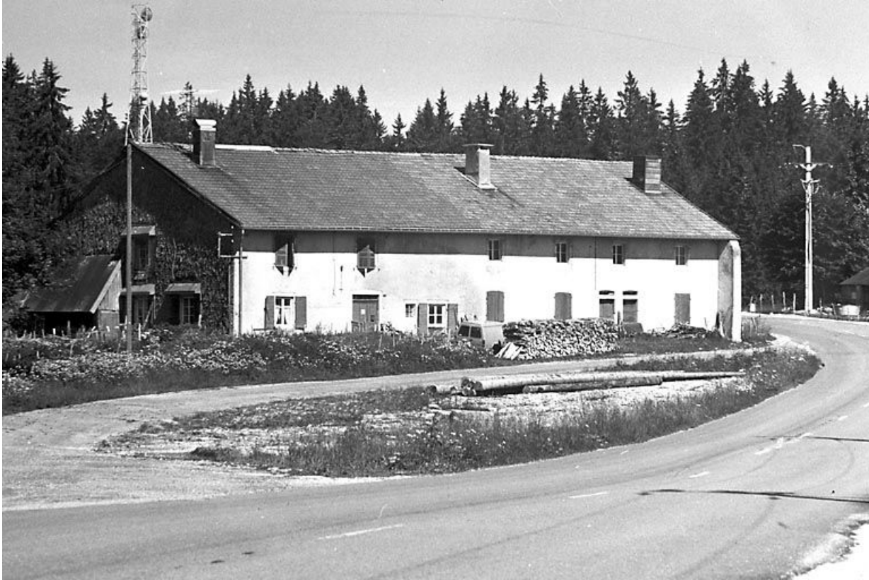
Vue éloignée de la façade antérieure.
