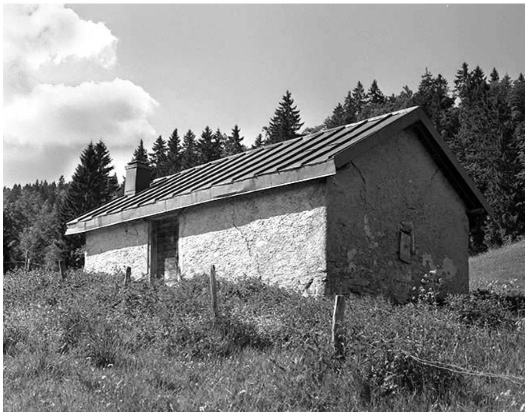
Façade antérieure et face droite vues de trois quarts.
