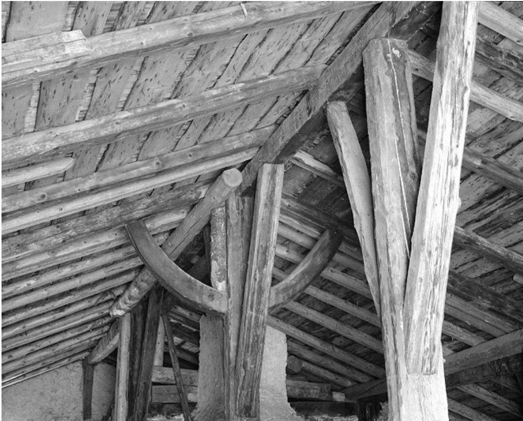
Charpente, colonne sous faitage et contrefiche.
