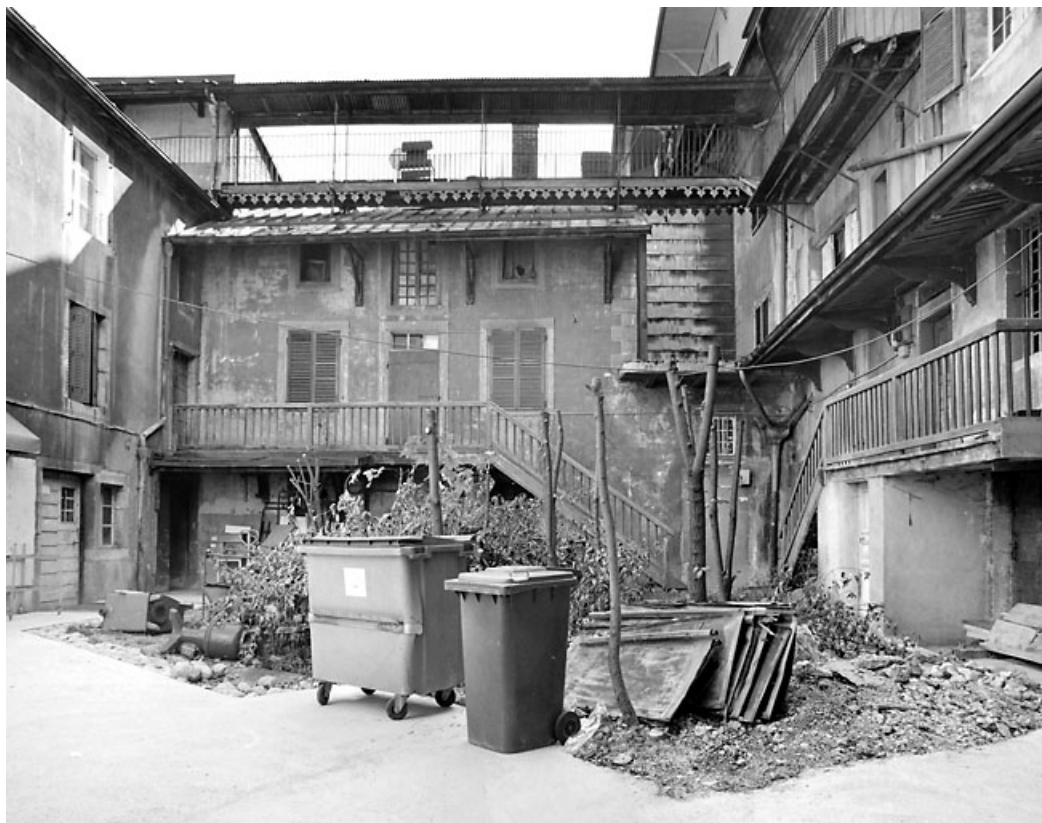
Vue d'ensemble de la cour, depuis le porche au nord.
