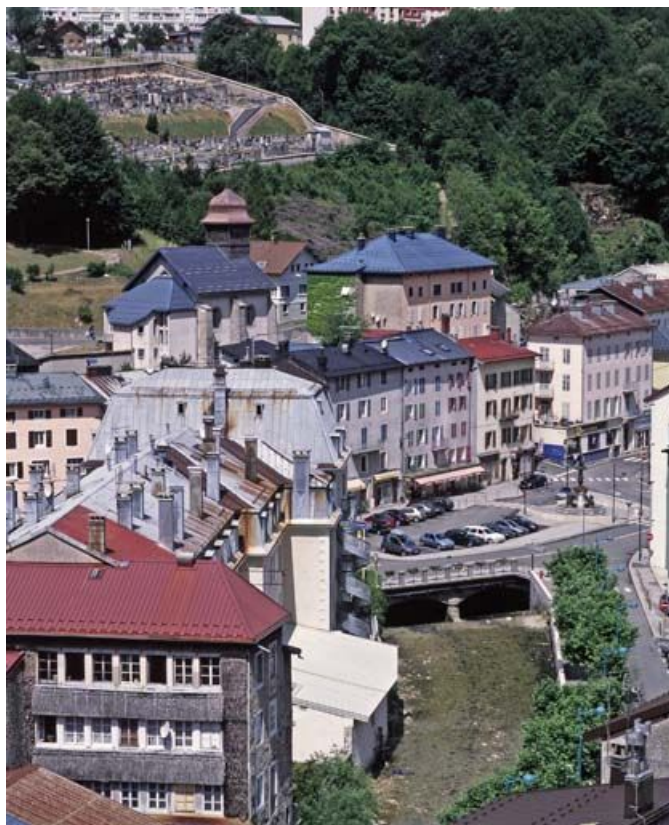
Vue d'ensemble plongeante, depuis l'est.
