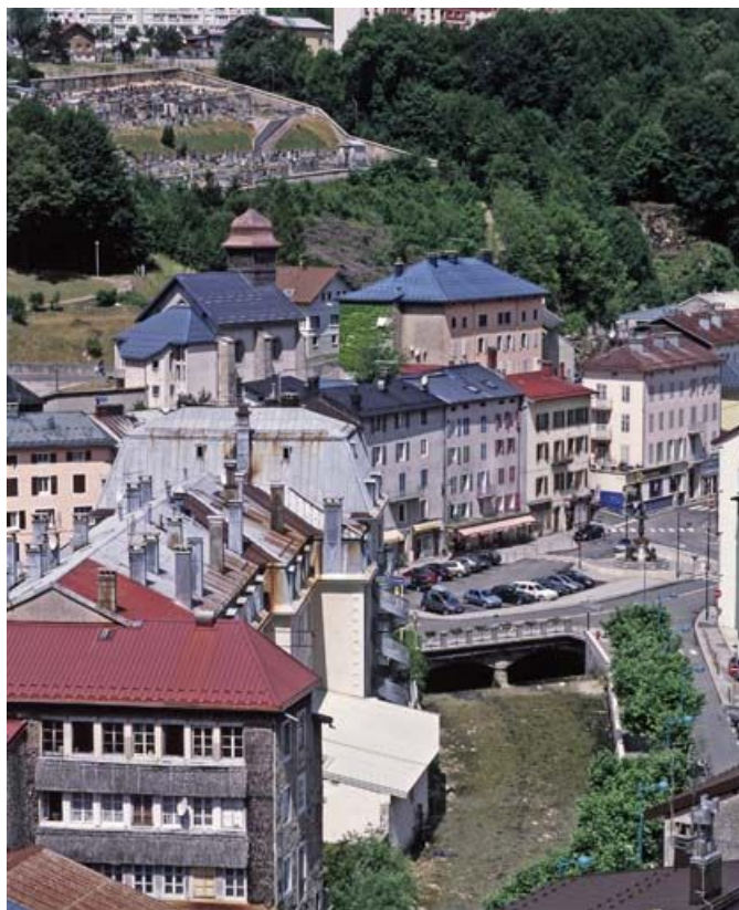
Vue d'ensemble plongeante, depuis l'est.
