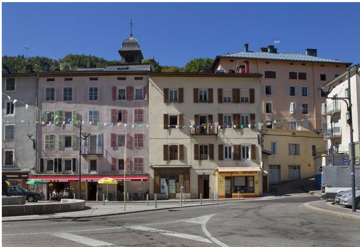
Le côté ouest et l'angle nord-ouest. A droite : au premier plan la rue de la République, à l'arrière-plan le quai Jobez. 39, Morez place Henri Lissac
