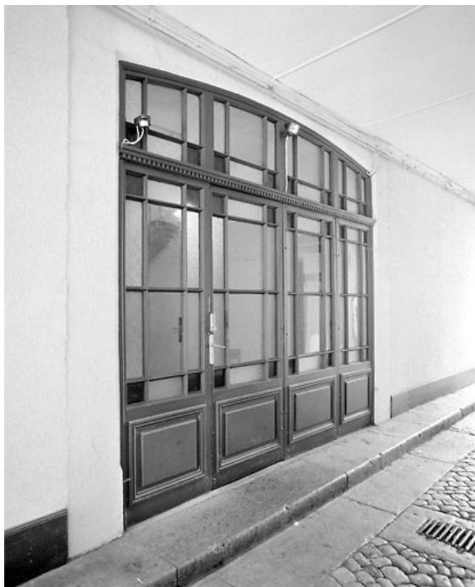
Passage couvert : porte de l'escalier.
