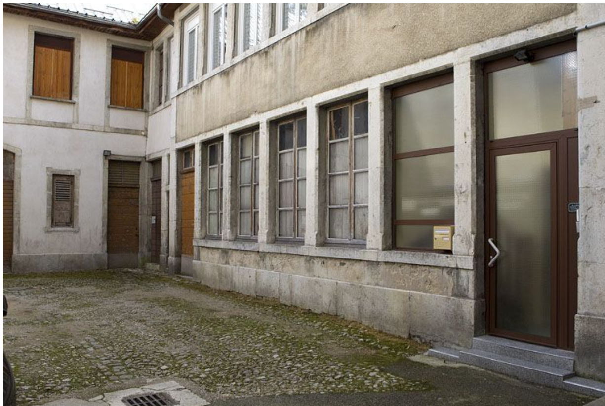
Immeuble (157 rue de la République) : atelier (à baies multiples) dans la cour. 39, Morez, 157 rue de la République
