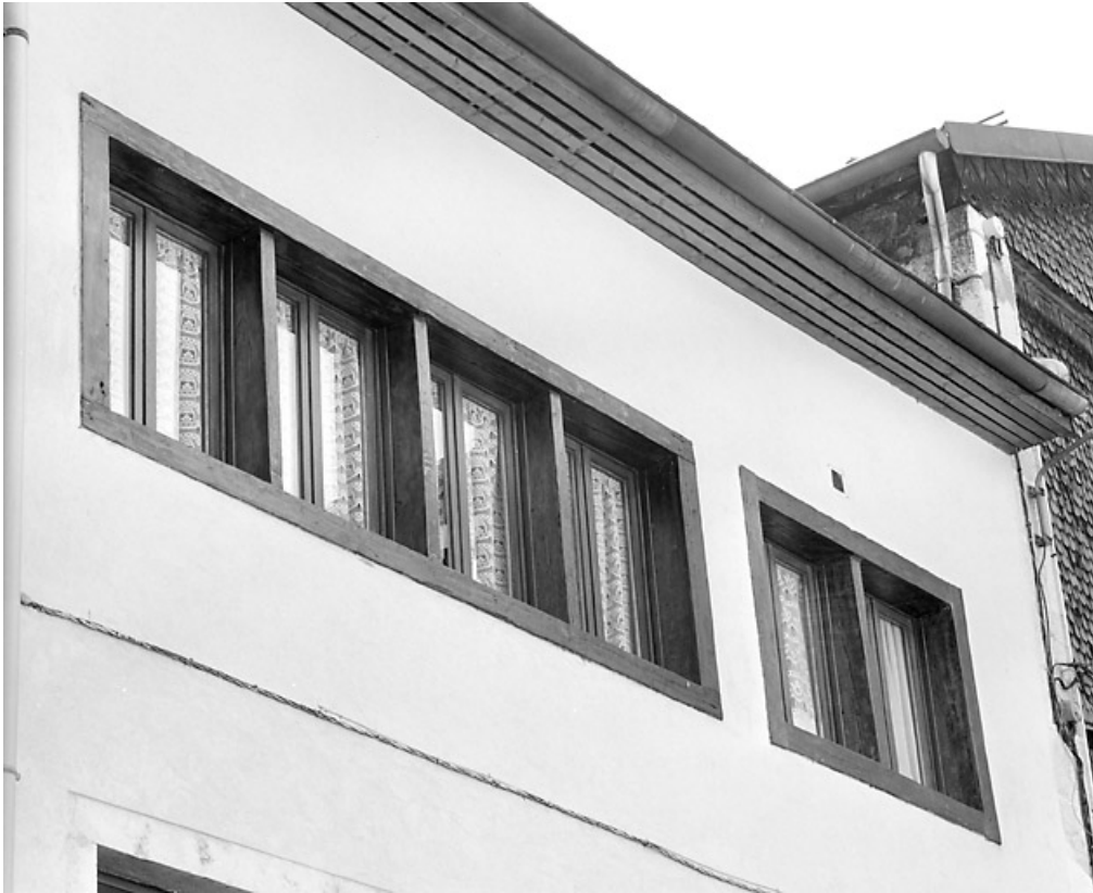
Aile sud : fenêtres lunetières du deuxième étage carré.
