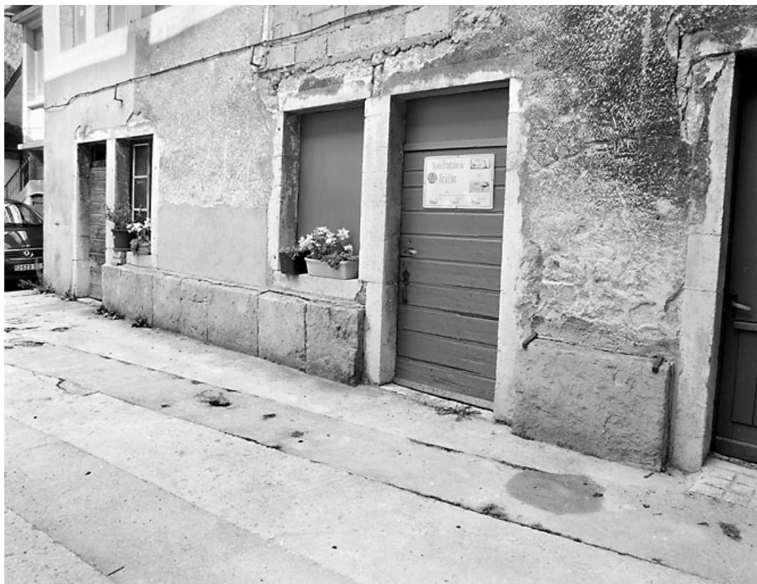
Aile nord : rez-de-chaussée, de trois quarts droite.
