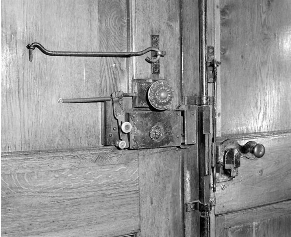
Porte principale : serrure et fermeture intérieure.
