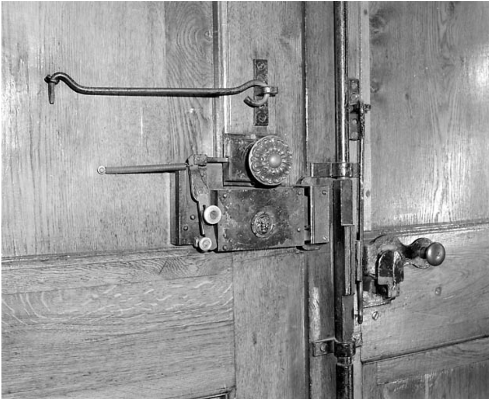
Porte principale : serrure et fermeture intérieure.
