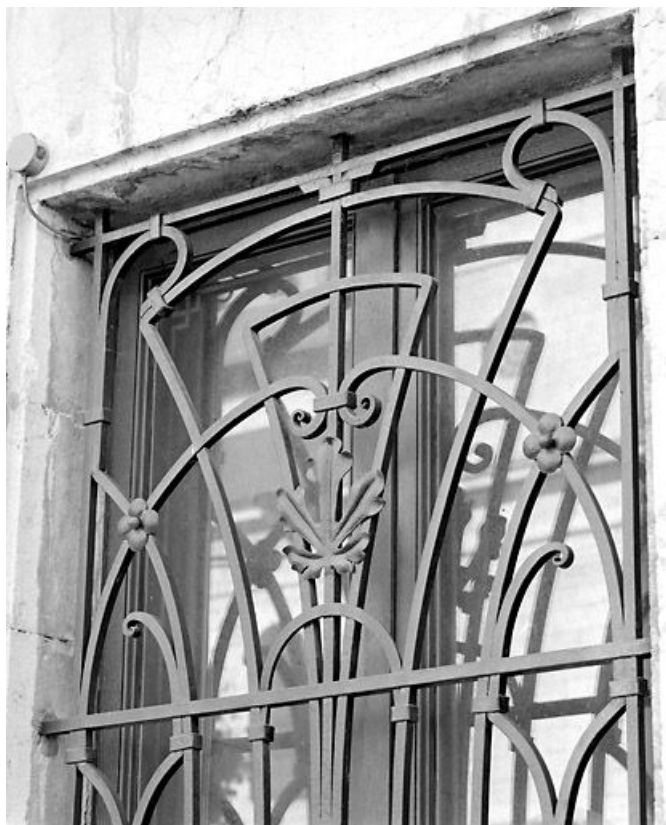
Façade latérale gauche : détail de la grille.
