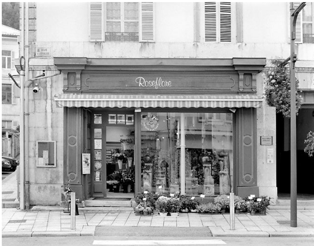
Façade antérieure : devanture de boutique.
