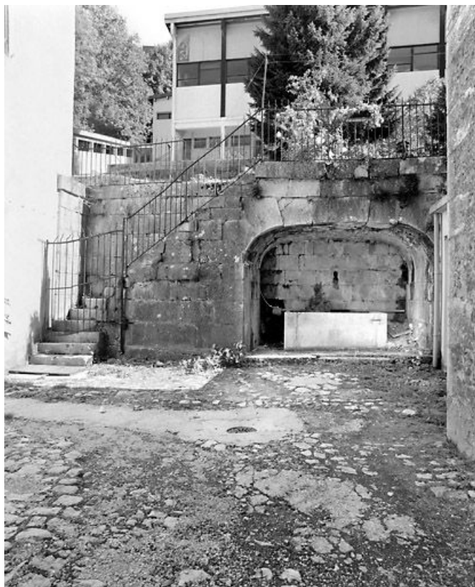
Mur de soutènement, escalier isolé et fontaine.
