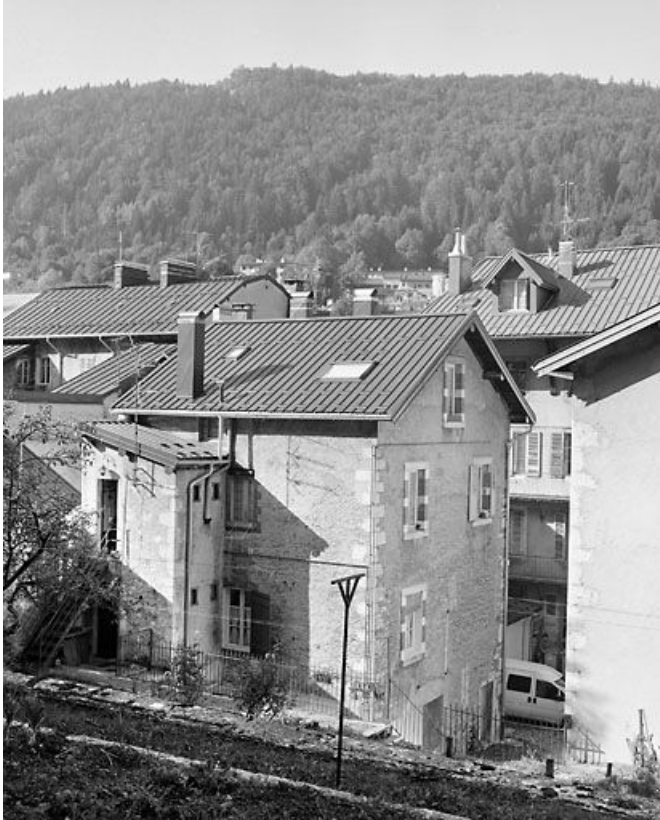
Bâtiment sud, vu du jardin.
