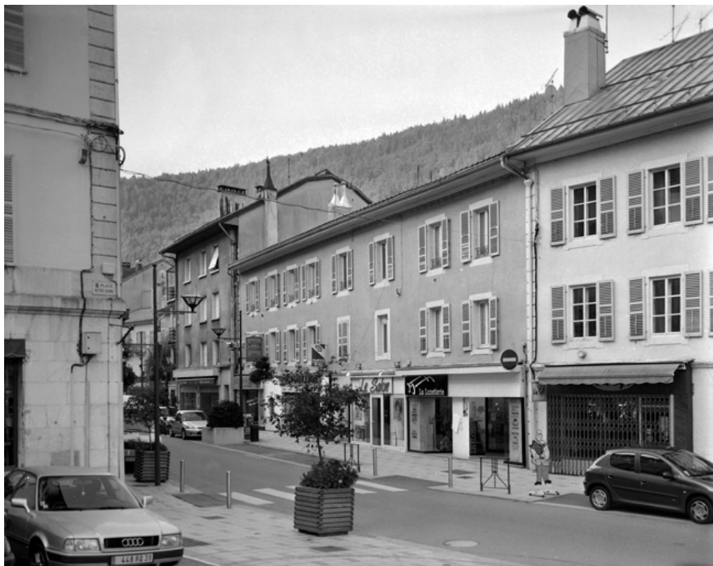
Vue d'ensemble, rue de la République.
