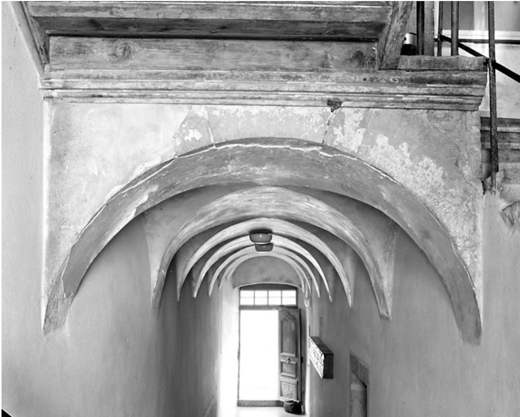
Voûte d'arêtes du couloir.
