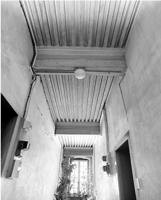
Plafond à la française dans le couloir du premier étage.
