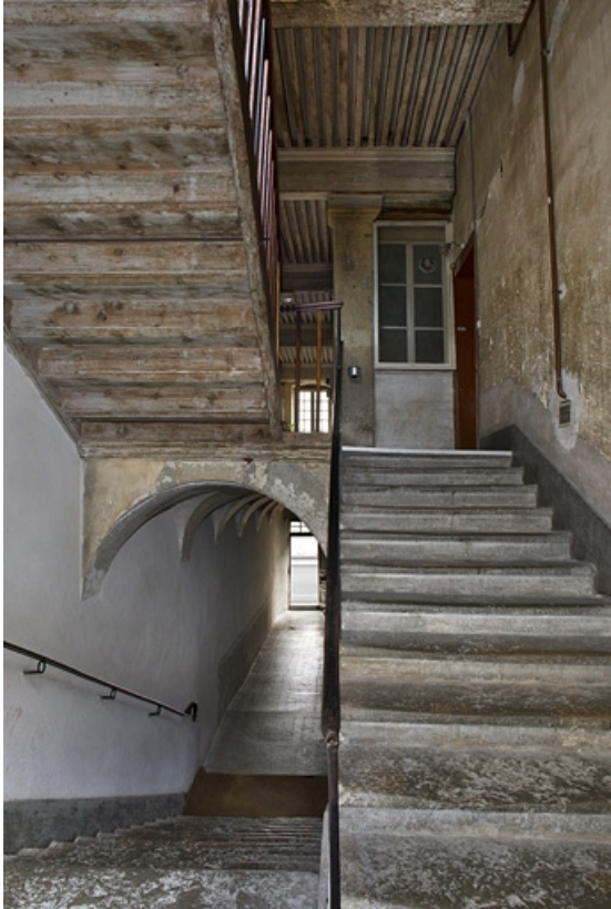
Escalier et couloir du premier étage, depuis le premier repos.
