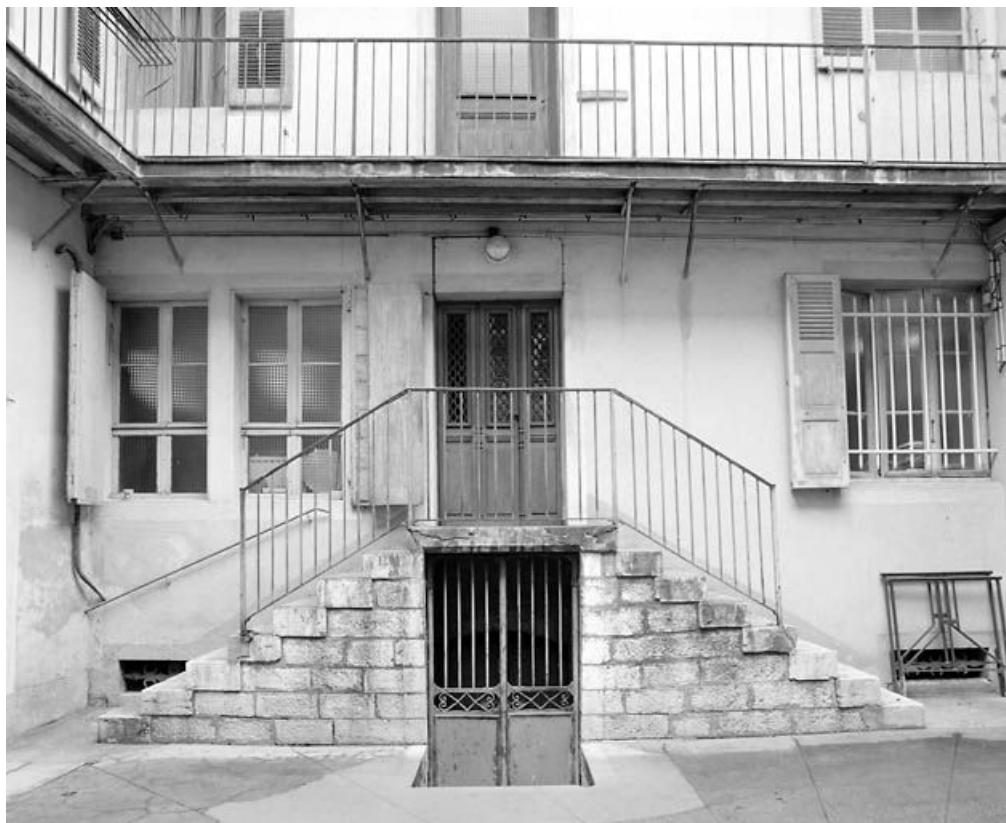
Façade postérieure : rez-de-chaussée surélevé et escalier extérieur.
