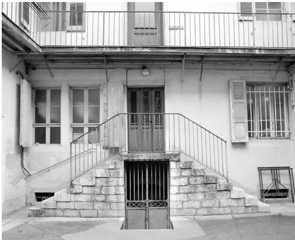
Façade postérieure : rez-de-chaussée surélevé et escalier extérieur.
