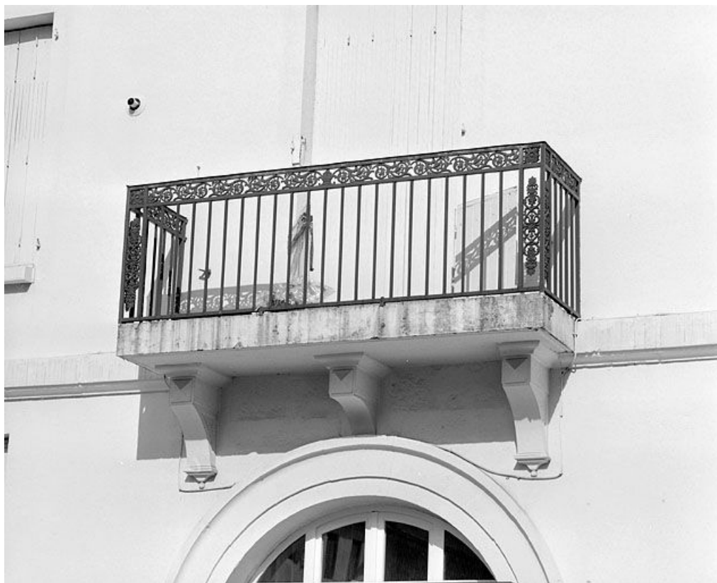
Façade latérale droite : balcon du premier étage.
