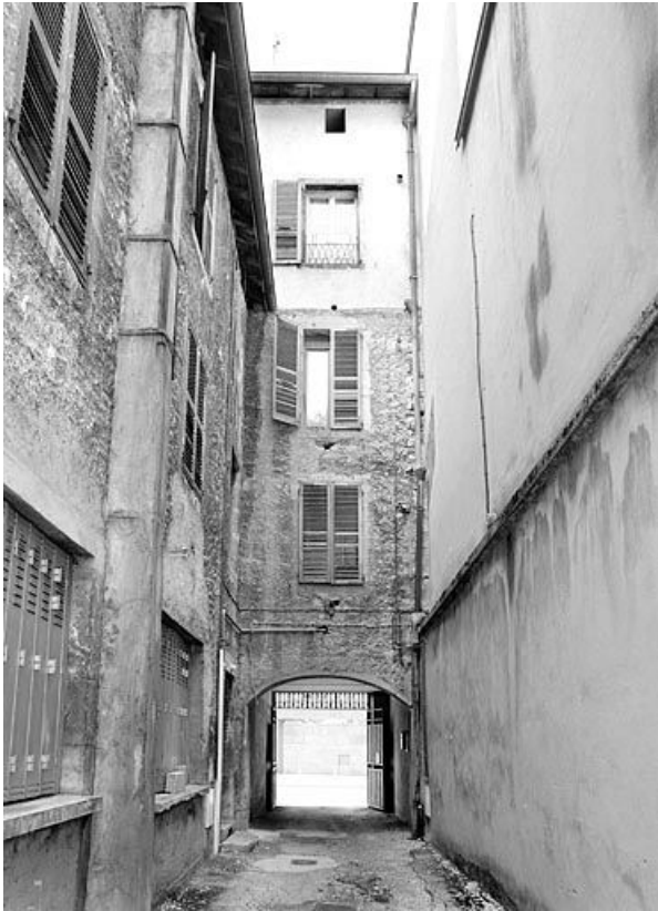
Façade postérieure du n° 141 et passage.
