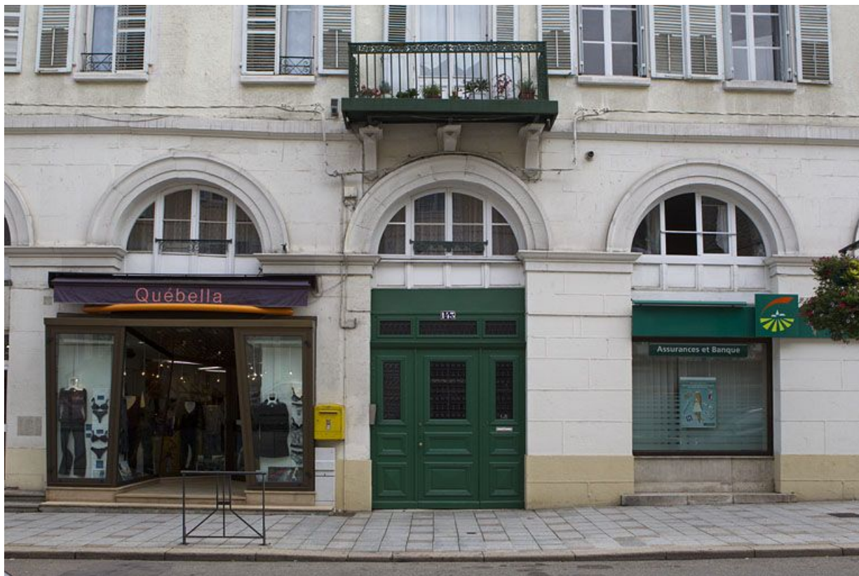
Façade antérieure : baies du rez-de-chaussée et de l'entresol, de face.
