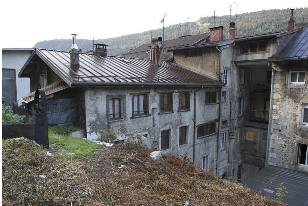
Façade postérieure et ancien atelier, depuis le nord-est.
