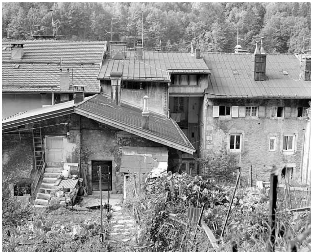
Ancien atelier : mur pignon oriental.
