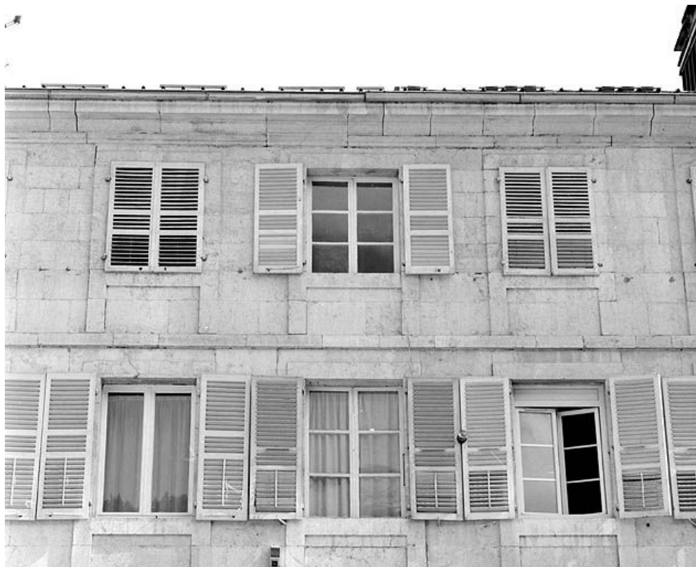
Façade antérieure des n° 131 et 133 : fenêtres aux 2e et 3e étages.
