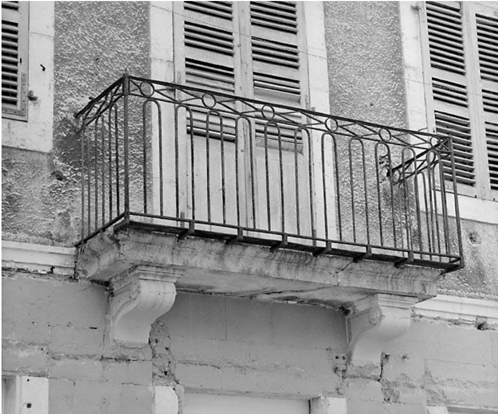
Balcon du corps de bâtiment oriental.
