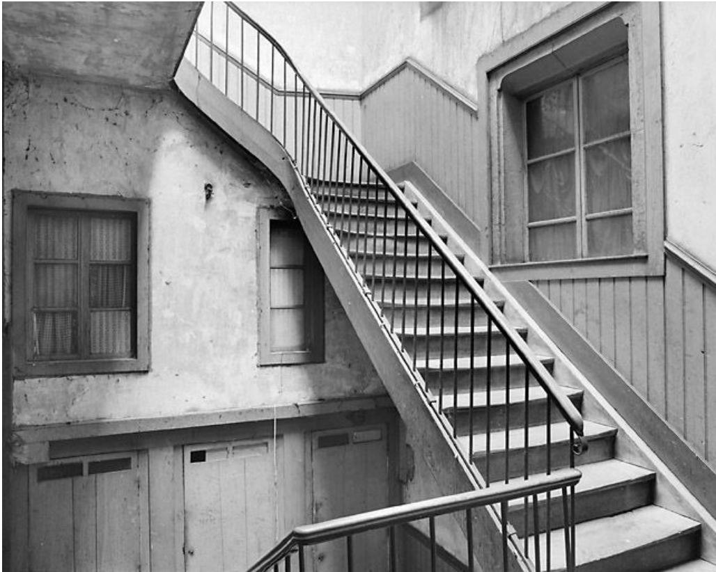
Escalier depuis le palier du premier étage.
