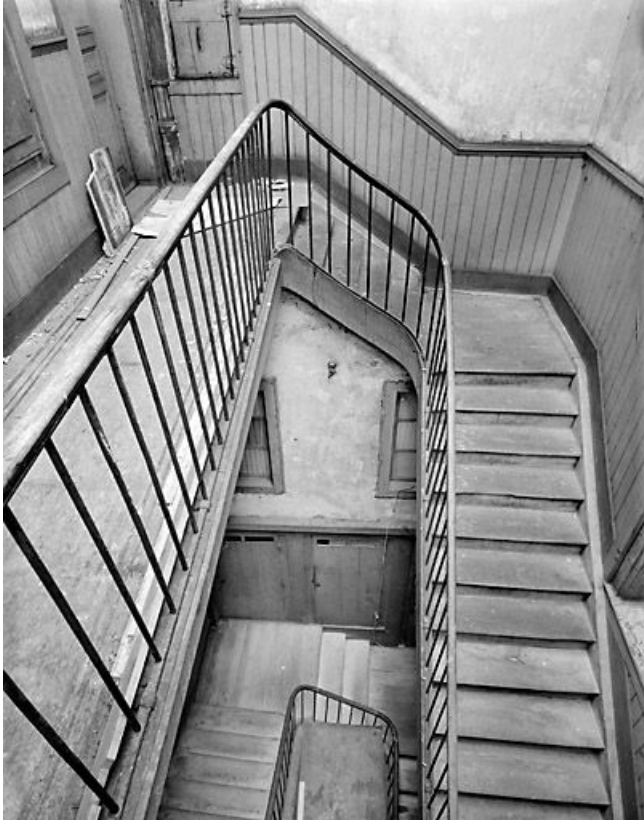
Vue plongeante sur la cage d'escalier.
