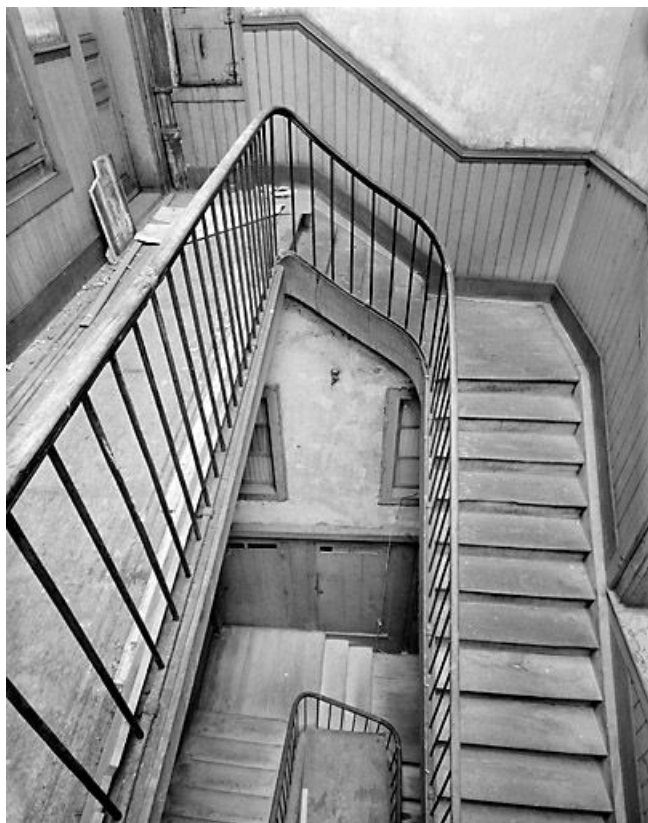
Vue plongeante sur la cage d'escalier.
