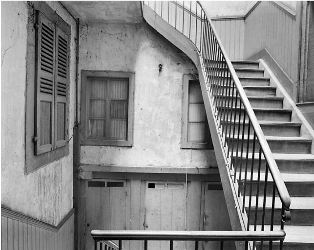
Cage d'escalier, au premier étage.
