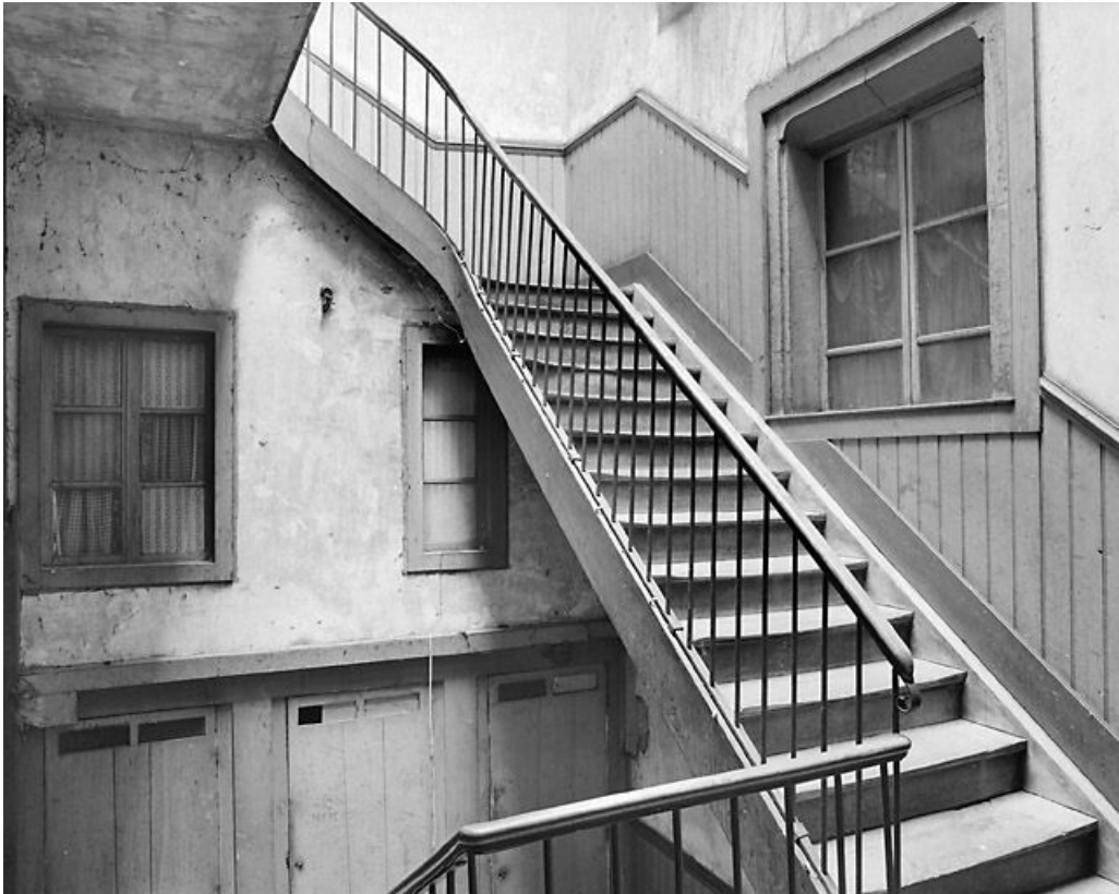
Escalier depuis le palier du premier étage.
