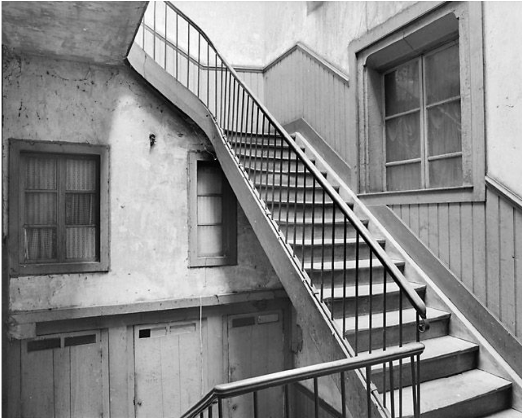
Escalier depuis le palier du premier étage.
