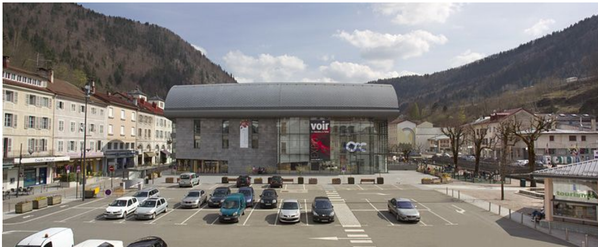
Vue d'ensemble depuis la mairie : côtés est (immeubles), sud (musée) et ouest (ancienne promenade). 39, Morez place Jean Jaurès
