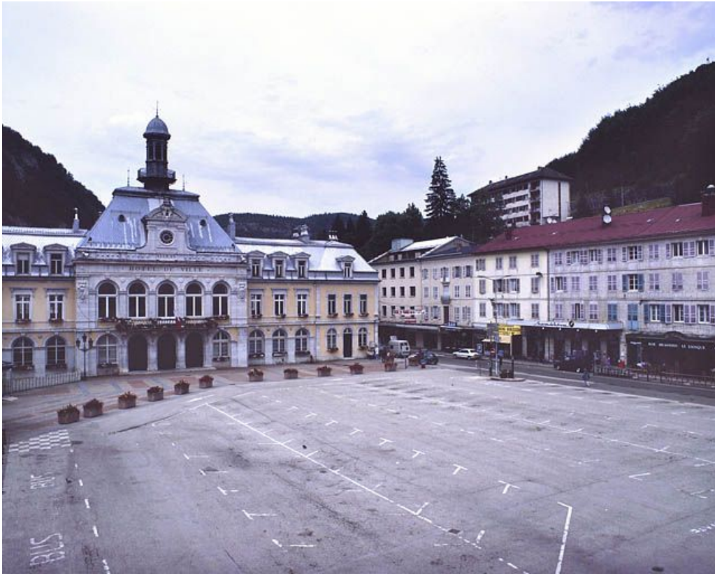
Vue d'ensemble, depuis l'angle sud-ouest : côtés nord (mairie) et est (immeubles). 39, Morez place Jean Jaurès
