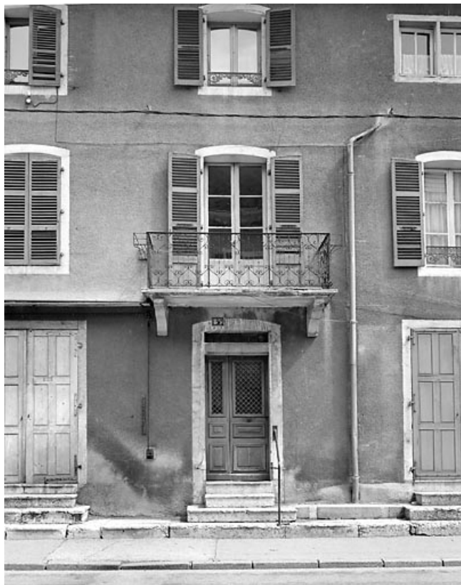
Façade antérieure : travée centrale.
