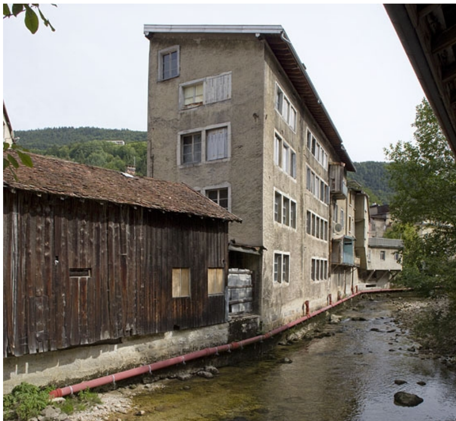
Façades postérieure et latérale gauche de l'atelier, depuis le nord.
