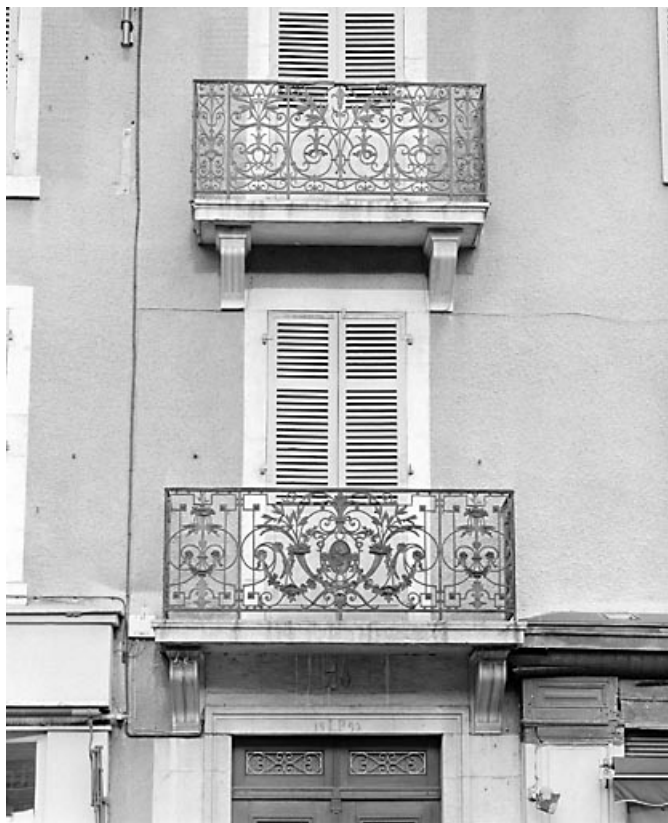
Balcons surmontant la porte d'entrée, avant restauration.
