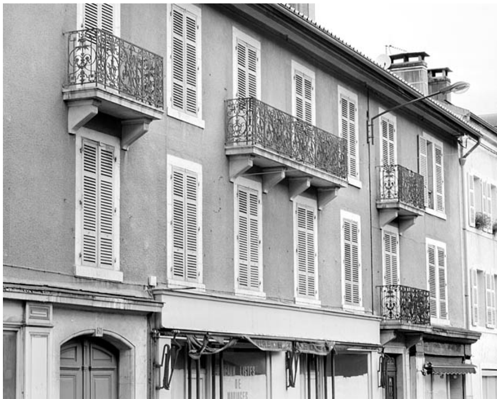
Façade antérieure, avant restauration : étages carrés, de trois quarts gauche. 39, Morez, 70 rue de la République
