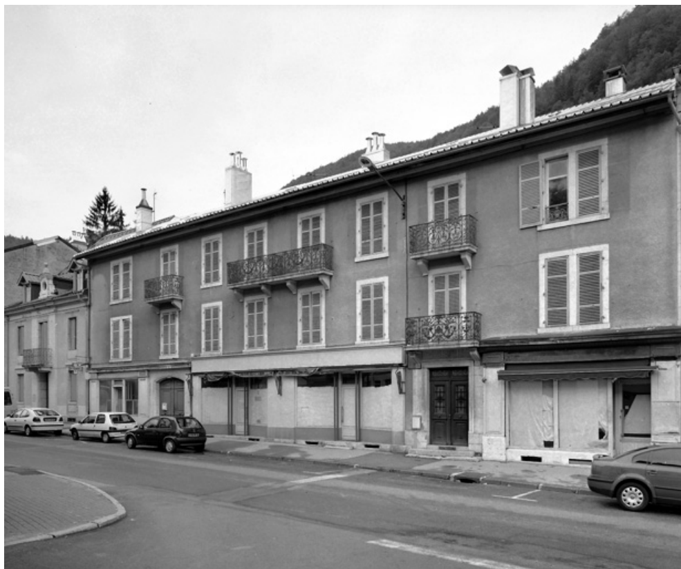
Façade antérieure de trois quarts droite, avant restauration.
