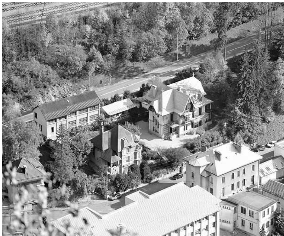
Vue d'ensemble plongeante, depuis l'ouest.
