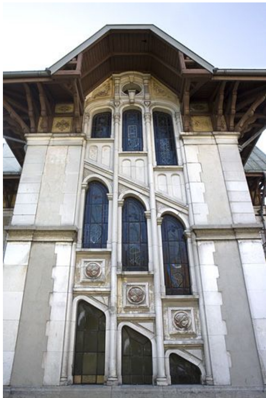
Élévation latérale gauche, en contre-plongée.
