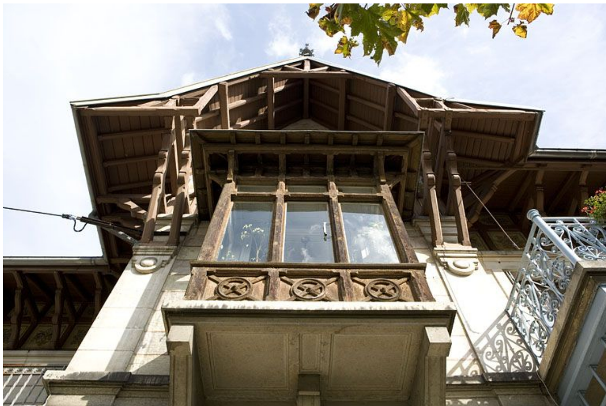
Élévation antérieure : la logette, vue en contre-plongée.
