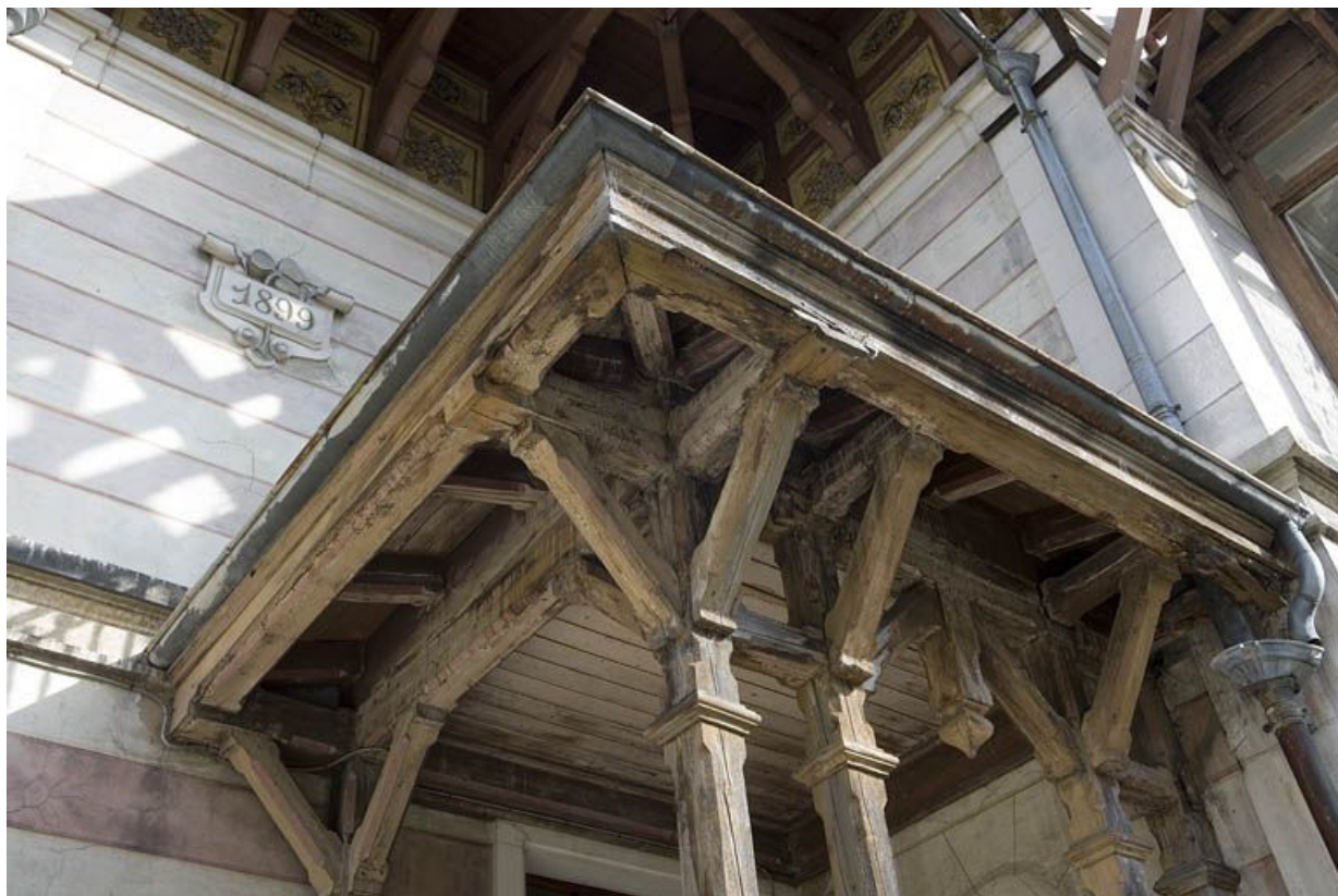
Élévation antérieure : charpente du porche.
