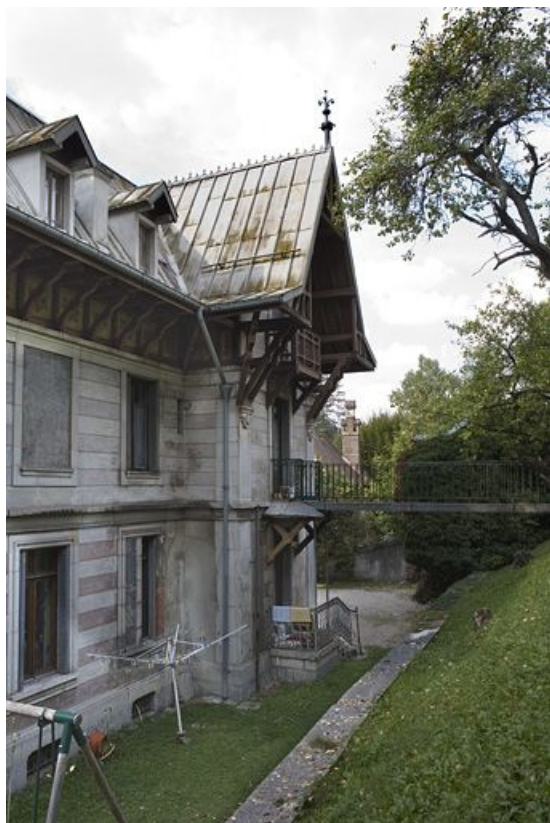
Élévation postérieure, de trois quarts gauche.
