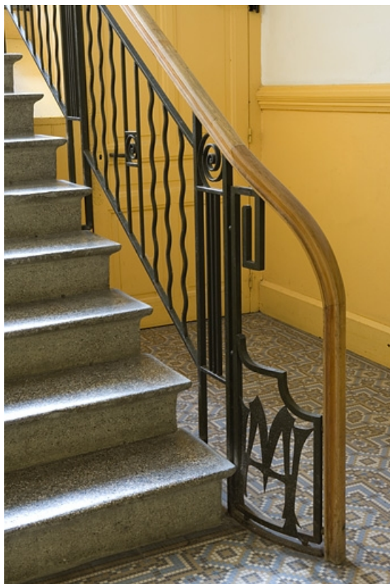
Rampe d'escalier, avec le monogramme MH.
