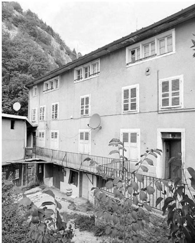
Façade principale : extension de 1861.
