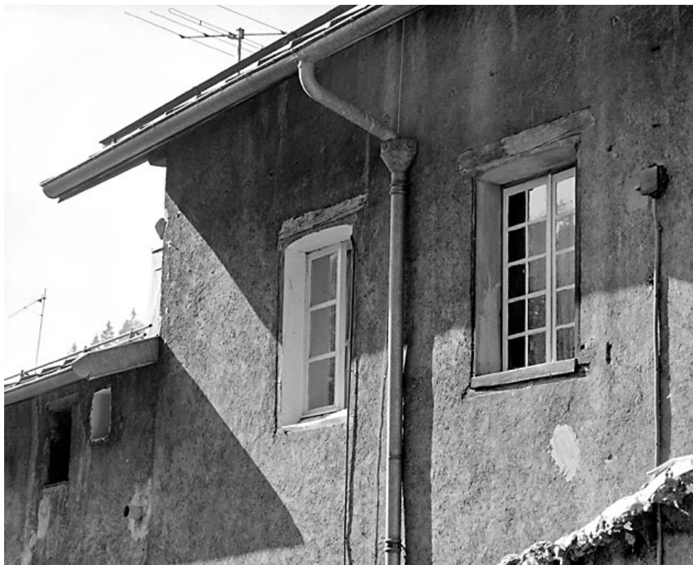
Façade postérieure : fenêtre du deuxième étage, à linteau en bois délardé en arc segmentaire. 39, Morez, 9 rue de la République
