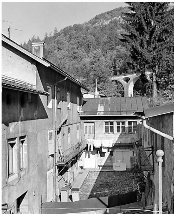
Façade postérieure, vue en enfilade.
