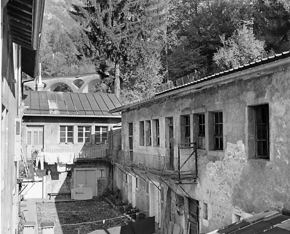
Cour et corps secondaires (nord-est au fond et est à droite).
