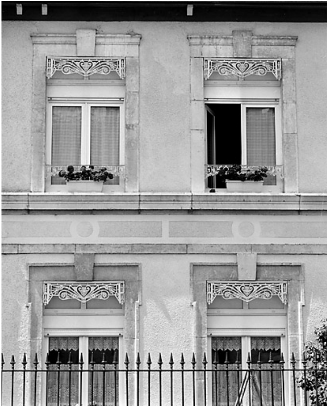
Élévation antérieure : baies.
