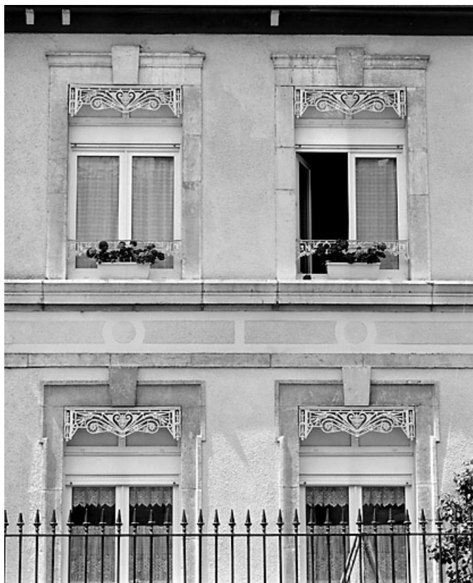
Élévation antérieure : baies.
