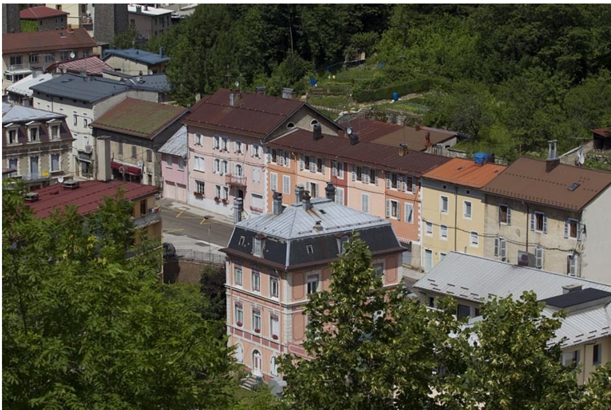
Vue d'ensemble plongeante, depuis le sud (élévations postérieure et latérale gauche).
