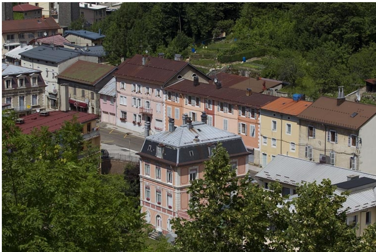
Vue d'ensemble plongeante, depuis le sud (élévations postérieure et latérale gauche). 39, Morez, 14 rue de la République
