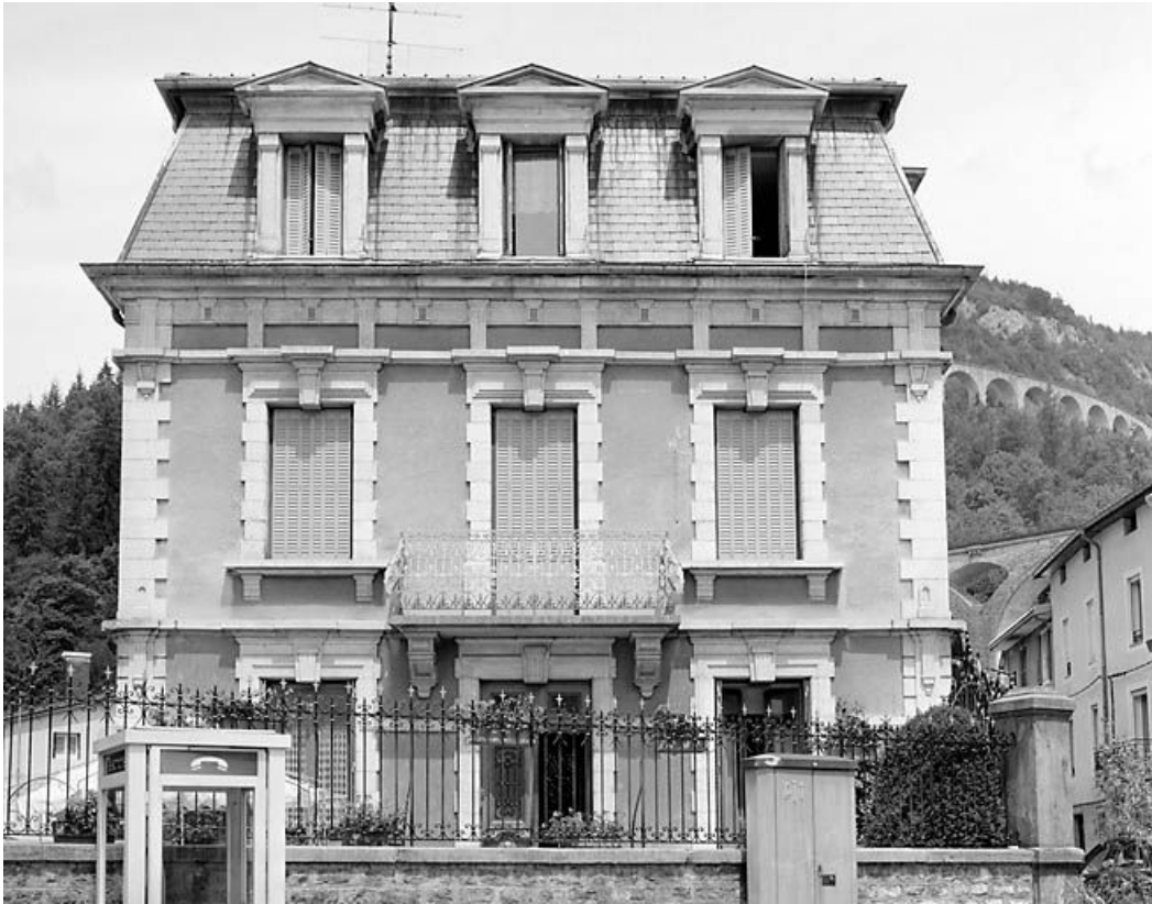
Élévation latérale gauche (vue rapprochée).
