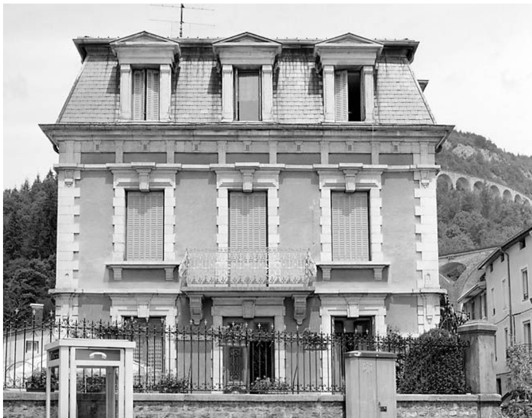
Élévation latérale gauche (vue rapprochée).
