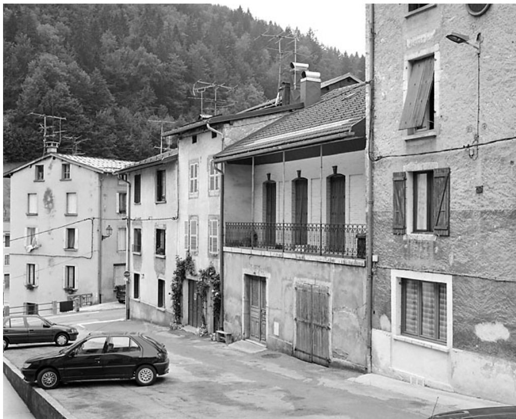
Corps de bâtiment 4 rue Traversière : vue d'ensemble, de trois quarts droite. 39, Morez, 6 place Jules Girod
