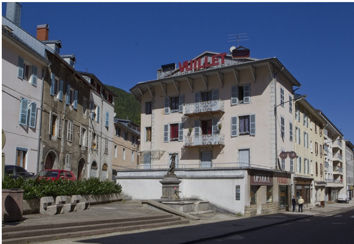
Vue d'ensemble, depuis le sud. 39, Morez rue de la République
