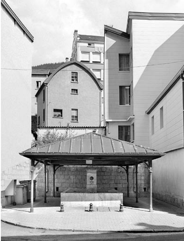
Fontaine-lavoir du quartier Mottet (entre les n° 71 et 73 rue de la République). 39, Morez
