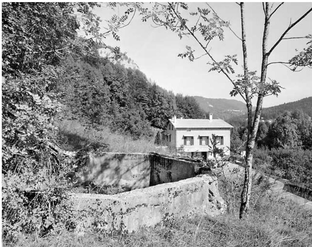
Réservoir au Pré vif.
