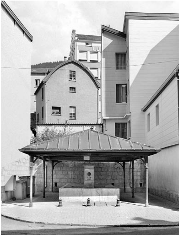
Fontaine-lavoir du quartier Mottet (entre les n° 71 et 73 rue de la République). 39, Morez
