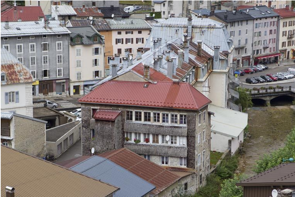
Vue d'ensemble plongeante, depuis l'est. 39, Morez, 5 rue du Docteur Regad
