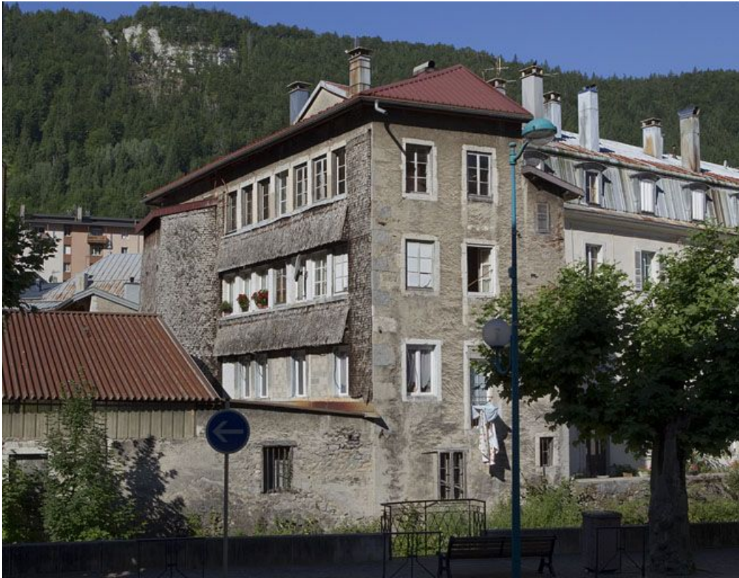
Façades postérieure et latérale droite.
