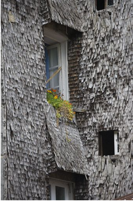
Détail des tavaillons et de la protection des fenêtres.
