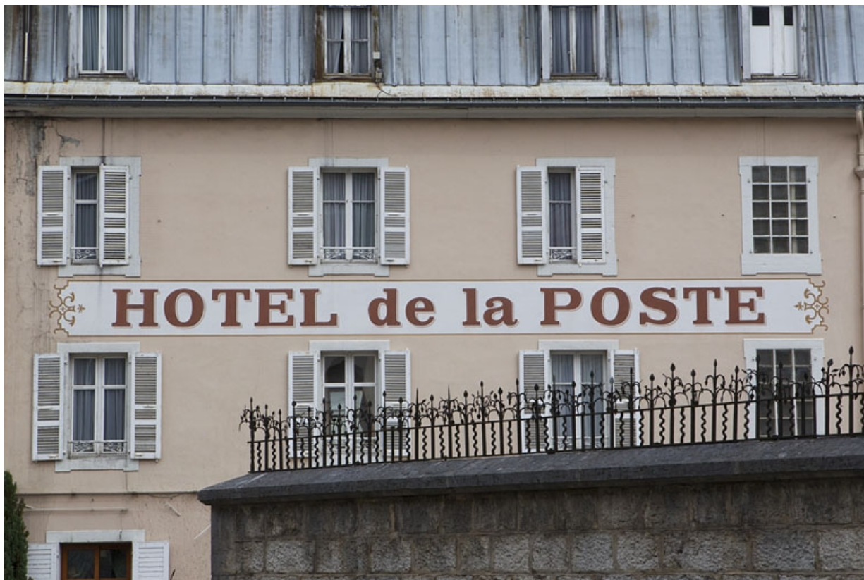
Partie ouest : enseigne sur la façade antérieure.
