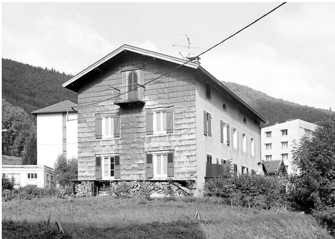
Façades postérieure et latérale droite.
