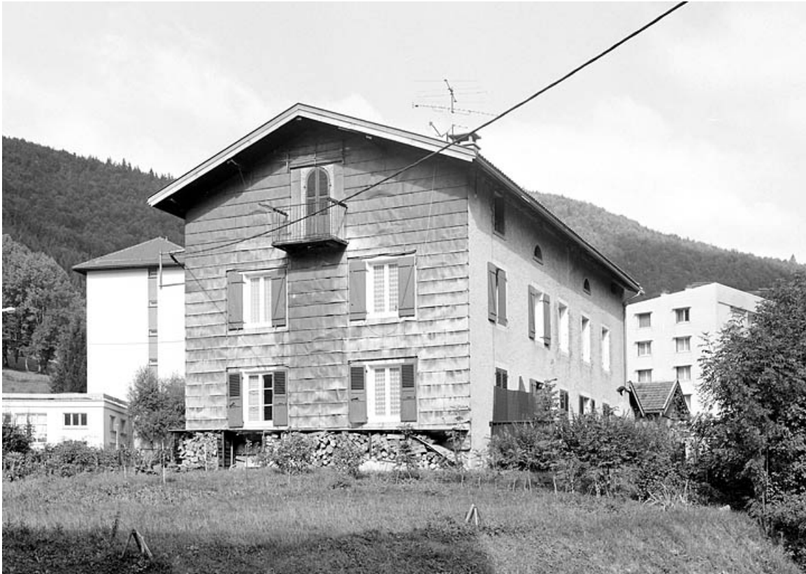
Façades postérieure et latérale droite.
