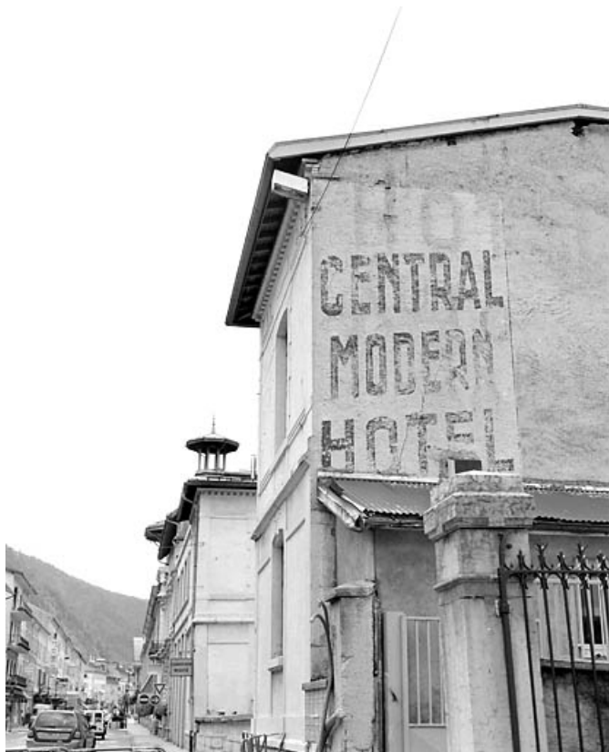
Enseigne peinte sur l'élévation latérale droite.
